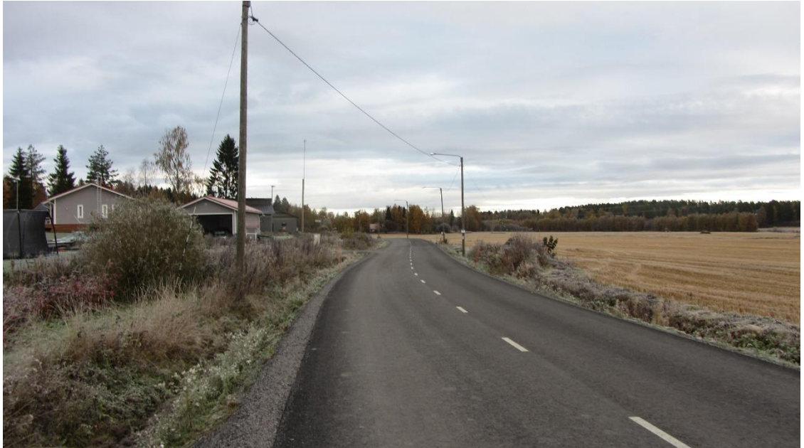
Kuva 4. Näkymä pohjoiseen Börentieltä, joka on suhteellisen kapea tie.
