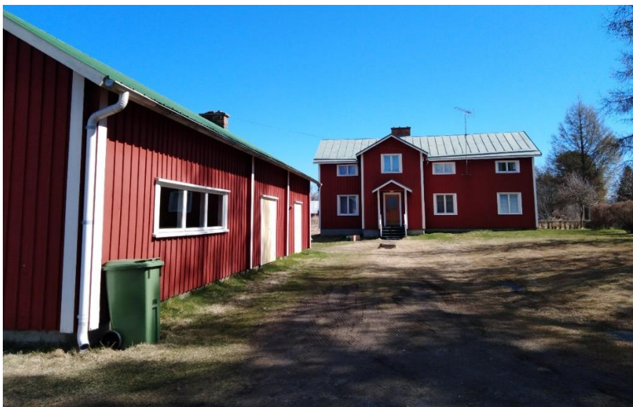
Kuva 15 Kyläsatamatien varrella sijaitsee Raippaluodon vanhinta rakennuskantaa.
