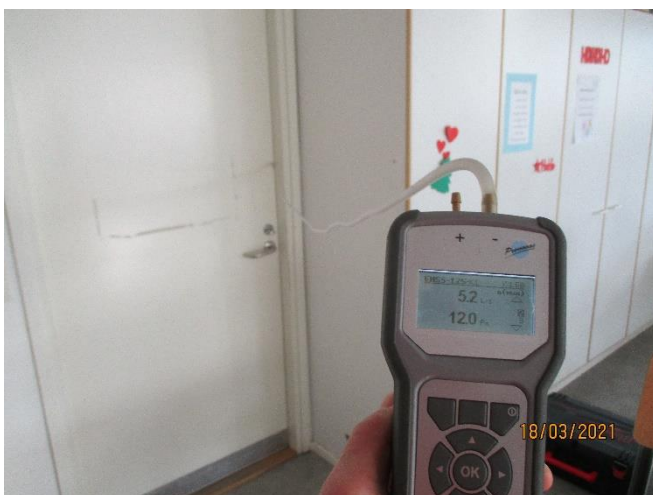
Bild 57. 12,0 Pa övertryck uppmättes i klassrummet jämfört med korridoren utanför.
