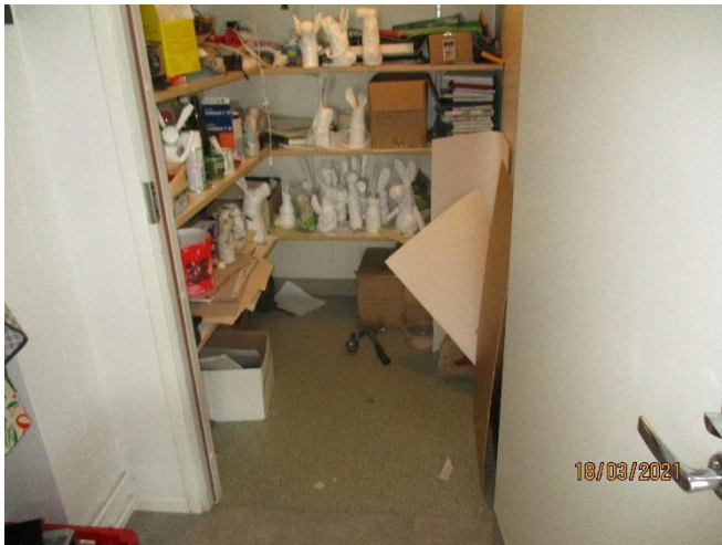
Bild 55. Förråd där golvkonstruktionen (mellanbjälklaget) kontrollerades.
