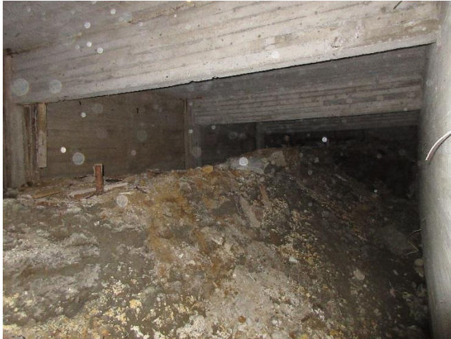
Bild 26. På markyta fanns synlig mikrotillväxt pga organiska material som brutits ner i krypgrunden.
