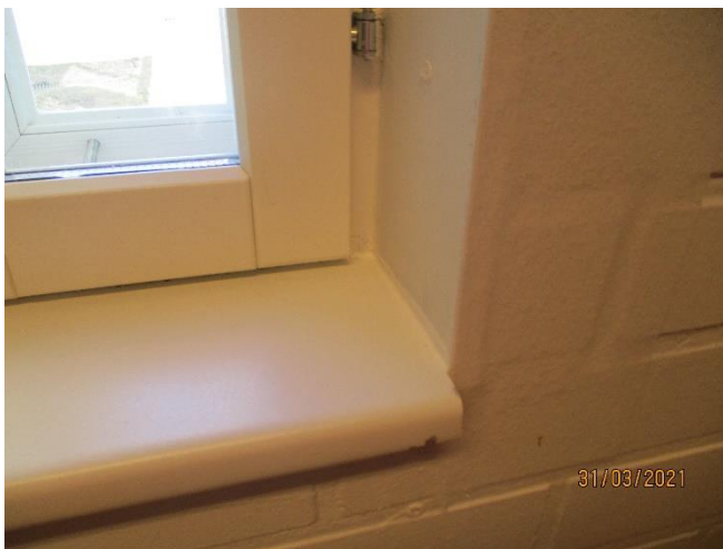
Bild 50. Fönstret hade återställts.
