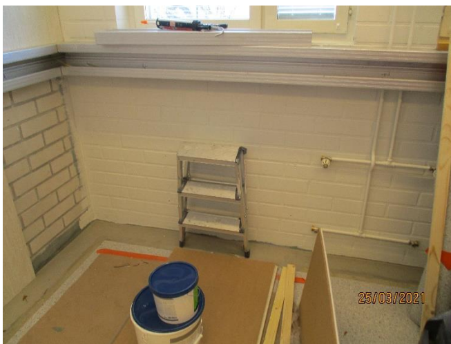
Bild 47. Arbetet har flyttat vidare till nästa rum. Samma princip för täthetsreparation används.
