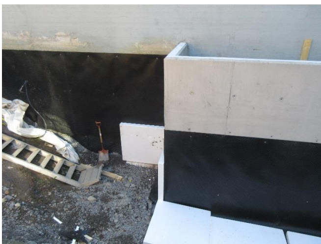
Bild 31. Ny grundmursskiva monterades på utsidan för att minimera fuktbelastningen.
