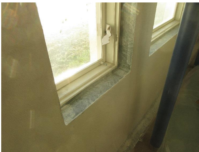
Bild 37. Täthetsreparering av fönsteranslutningar.
