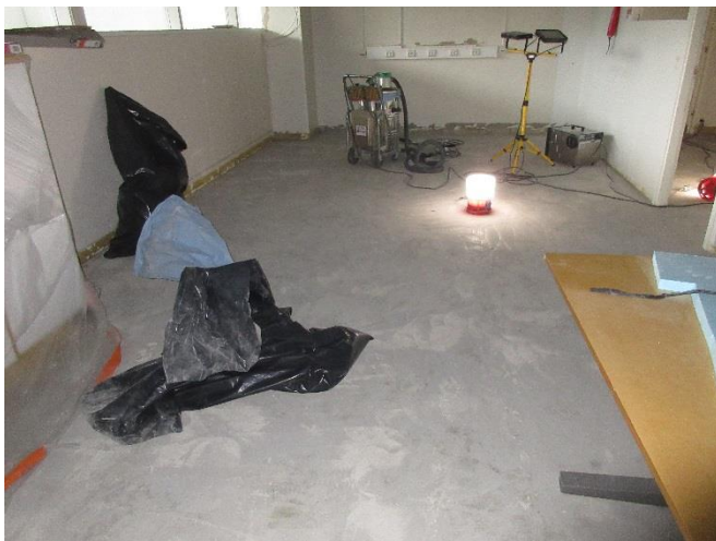
Bild 19. I biblioteket slipades golvet till ren betong.
