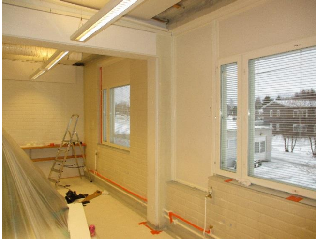
Bild 16. NÖ7. Täthetsreparation under arbete.
