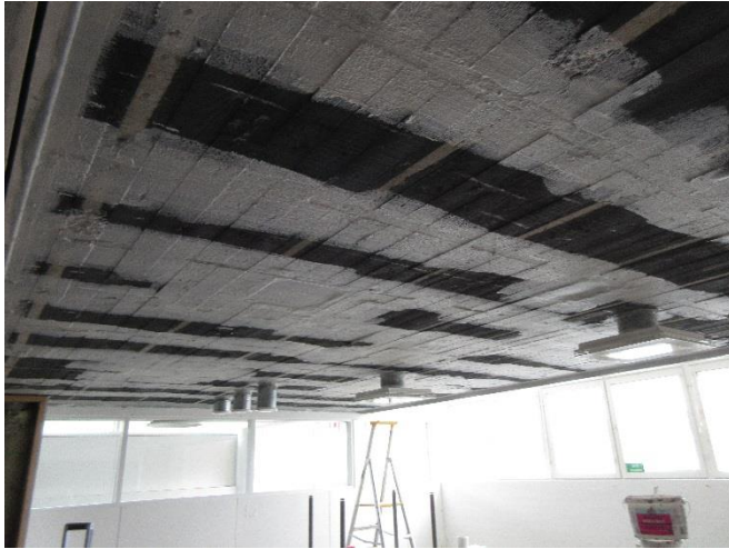
Bild 18. Täthetsreparation av tak i SÖ10.
