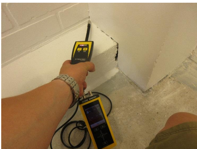
Bild 4. Läckageplatser söktes med givare.
