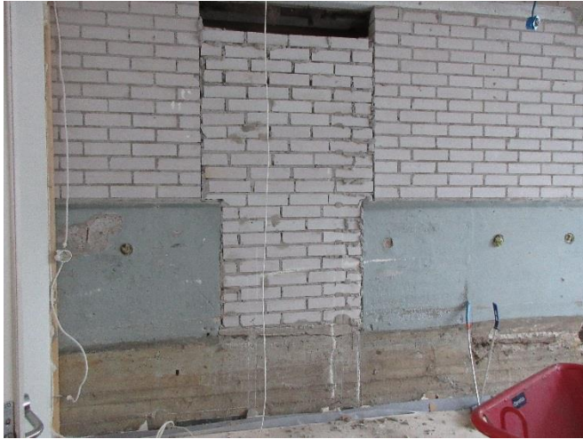
Bild 6. Väggen öppnades upp.
