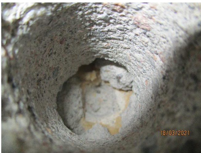
Bild 56. Ett runt lager med ullisolering finns mellan två betongskikt. Ingen avvikande lukt upplevdes.
