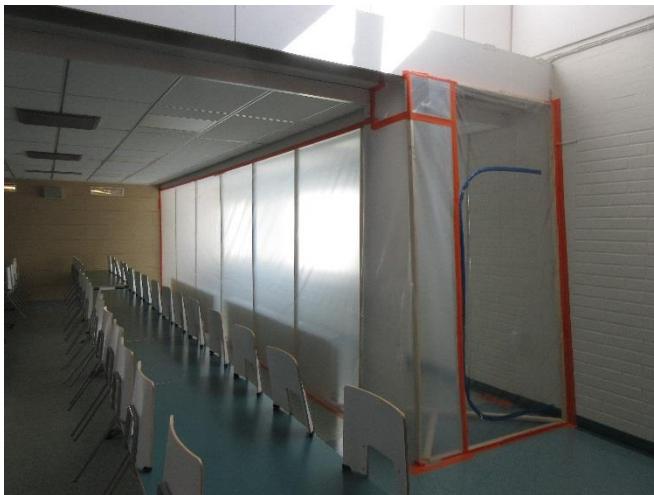
Bild 35. Matsalens yttervägg sektionerad. Väggen täthetsreparerades.
