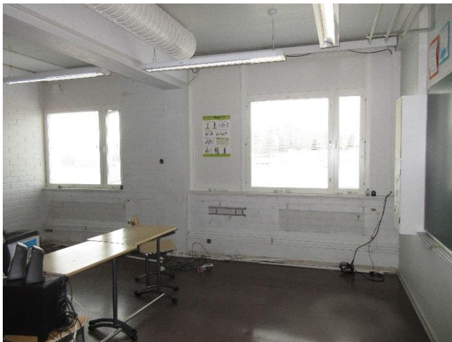
Bild 11. SÖ1. Täthetsreparation under arbete.
