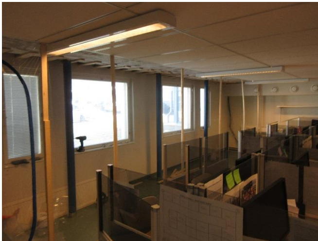
Bild 36. Sektionering av yttervägg under arbete i lärarrum.
