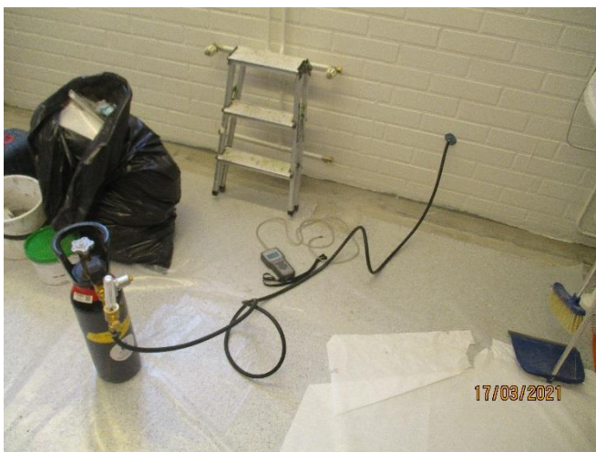
Bild 42. Spårgas sattes in i yttervägg. Undertryck inomhus säkerställdes men inget läckage konstaterades.
