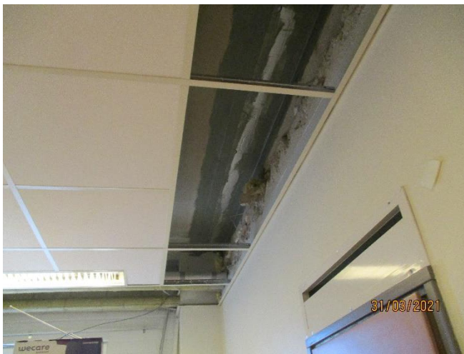
Bild 49. Man har följt samma princip för arbetsgången som tidigare. Tätning har utförts runt fönster och i vinklar.
