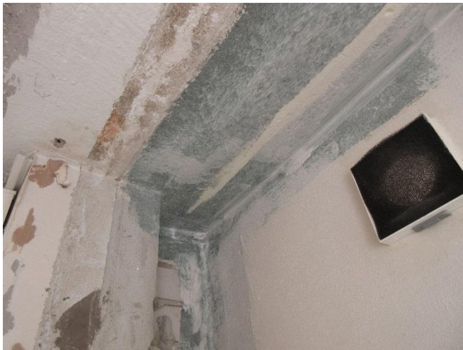
Bild 39. I lärarrummet täthetsreparerades även övre kant på grund av de skenor som gick emellan utrymmena.
