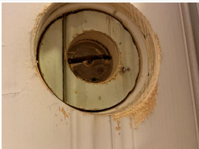
5.7.1. Bild från håltagning i yttervägg från insidan
