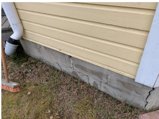
5.4.3. Under den tillbyggda farstun finns lecasockel, som har en del skador
