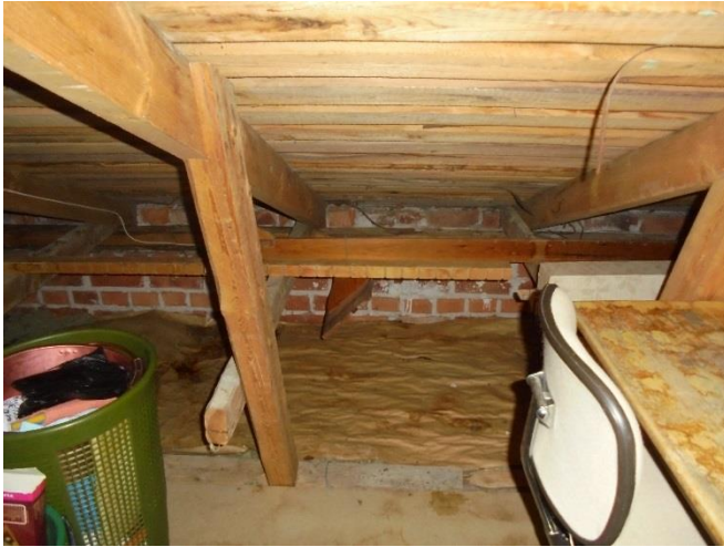
Bild 16. Bostadshusets kallvind. Utsikten är inte öppna. Takkonstruktionen ligger mot väggkonstruktionen.
