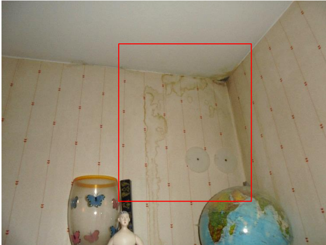
Bild 32. Rinnmärken observerades i översta lägenheten på två ställen.
