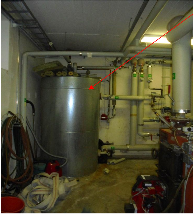
Bild 51. Varmvattenberedare.
