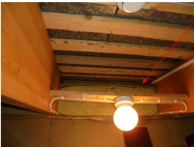
Bild 21. En ventilationsspalt observerades mellan isoleringen och vattentaket.
