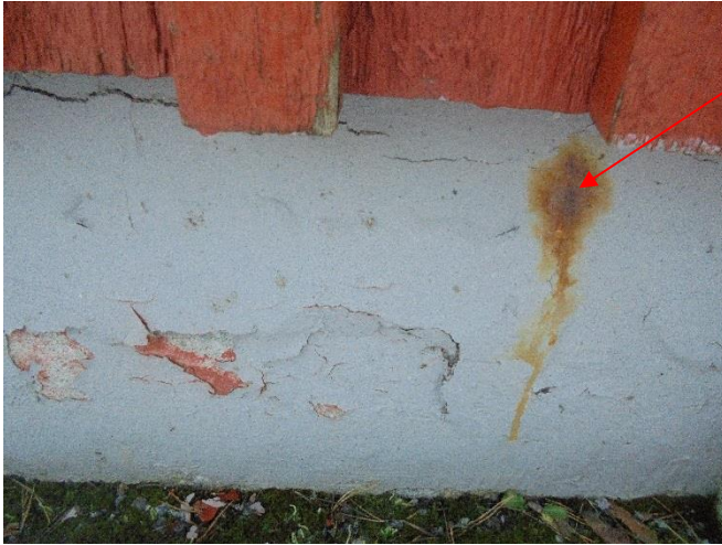
Bild 3. Målarfärgen flagnar och ställvis observerades rostfläckar på sockeln.
