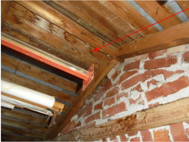
Bild 19. Rinnmärken observerades på träkonstruktionerna vidnocken samt på övriga platser.
