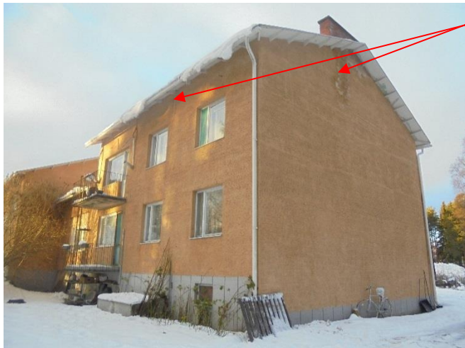
Bild 5. På bostadsdelen observerades rinnmärken på fasaden.
