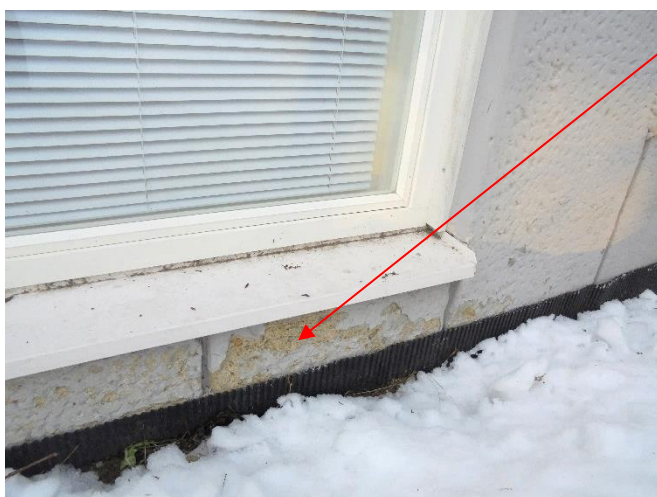
Bild 2. Målarfärgen flagnar ställvis på sockeln.
