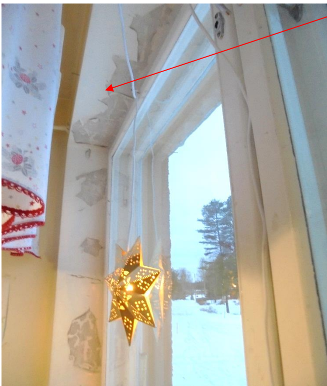
Bild 33. Målarfärgen flagnar runt fönstren på framsidan.
