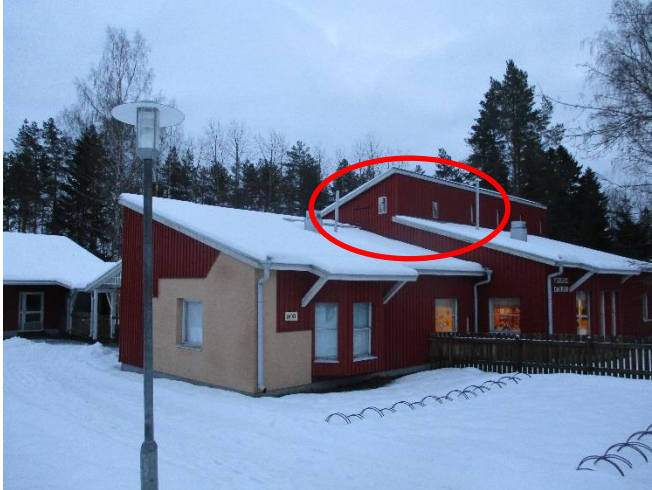
Bild 42. Dagsbyggnaden Avloppsventilationsrören är nära luftintaget.
