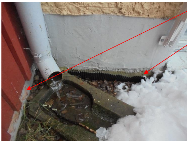
Bild 1. Målarfärgen flagnar ställvis från sockeln.
