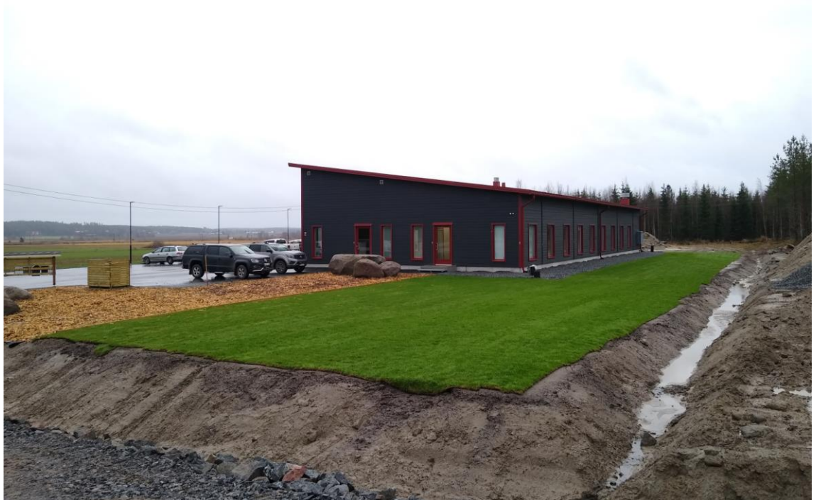
Kuva 2. Kaava-alueelle äskettäin rakennettu yrityshotelli.
