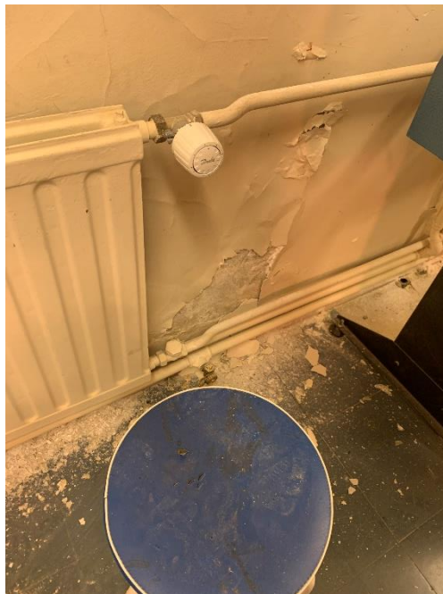
5.2.4. Ytterväggen i snickeriet var vid mätningstillfället torr men fuktskadad
