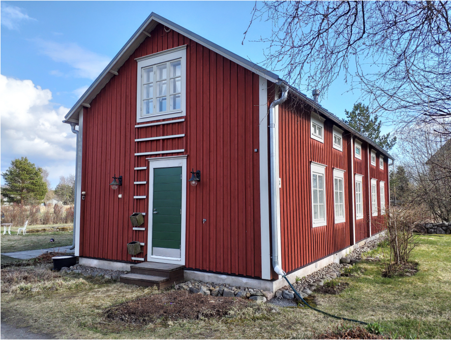
Skyddad byggnad som förlängts längs Kyrkvägen.
