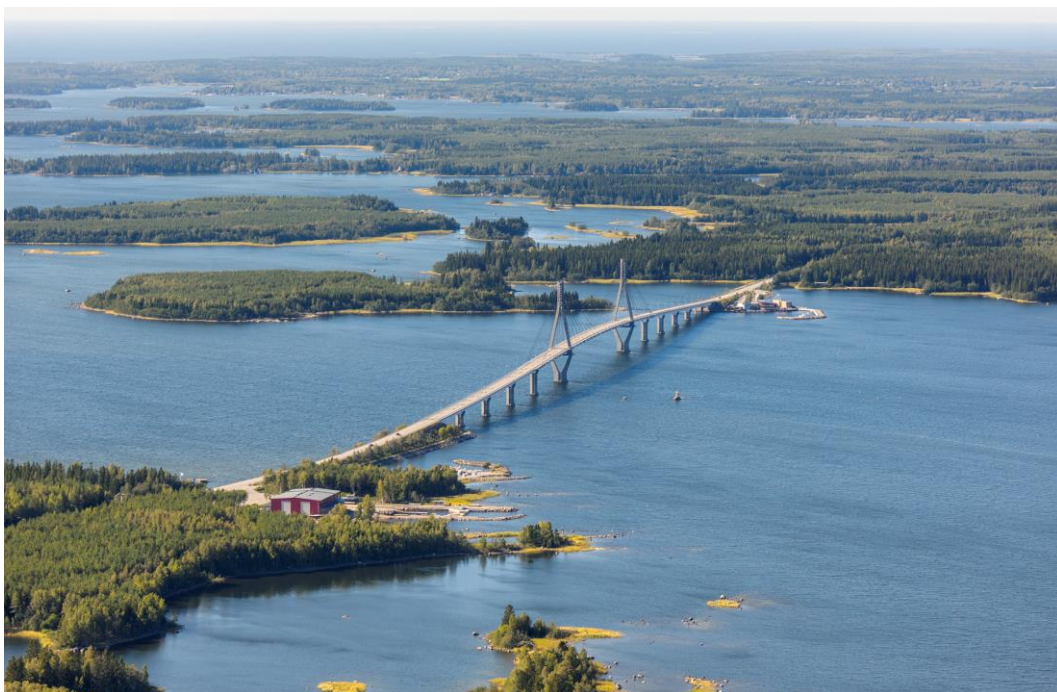
Bild 26 Snedbild från nordost över Kvarkens skärgård. I förgrunden syns Replotbron och på den västra sidan Bergskäret. (Bild Korsholms kommun 2018)
