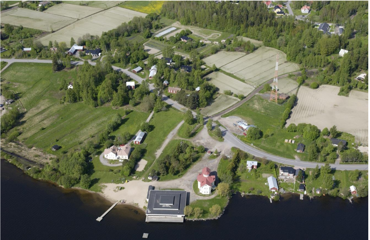
Kuva 2. Vanha ilmakuva Karperön uimarannasta lähiympäristöineen. Kuvassa paviljongin molemmin puolin näkyvät rakennukset on sittemmin purettu.
