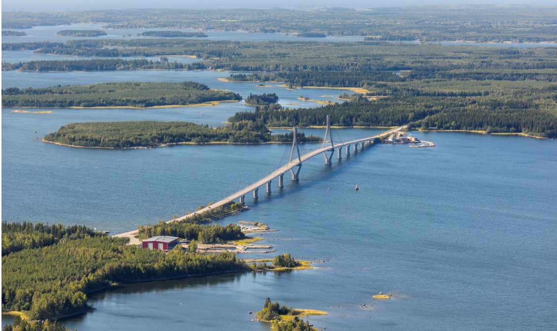
Kuva 29 Viistokuva koillisesta Merenkurkun saaristoon. Etualalla Raippaluodon silta ja sen vasemmalla puolella sijaitseva Bergskäret. (Kuva Mustasaaren kunta 2018)
