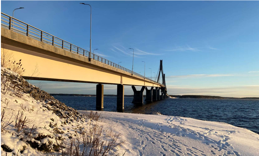
Kuva 20 Kuvassa Raippaluodon silta talvella 2021.
