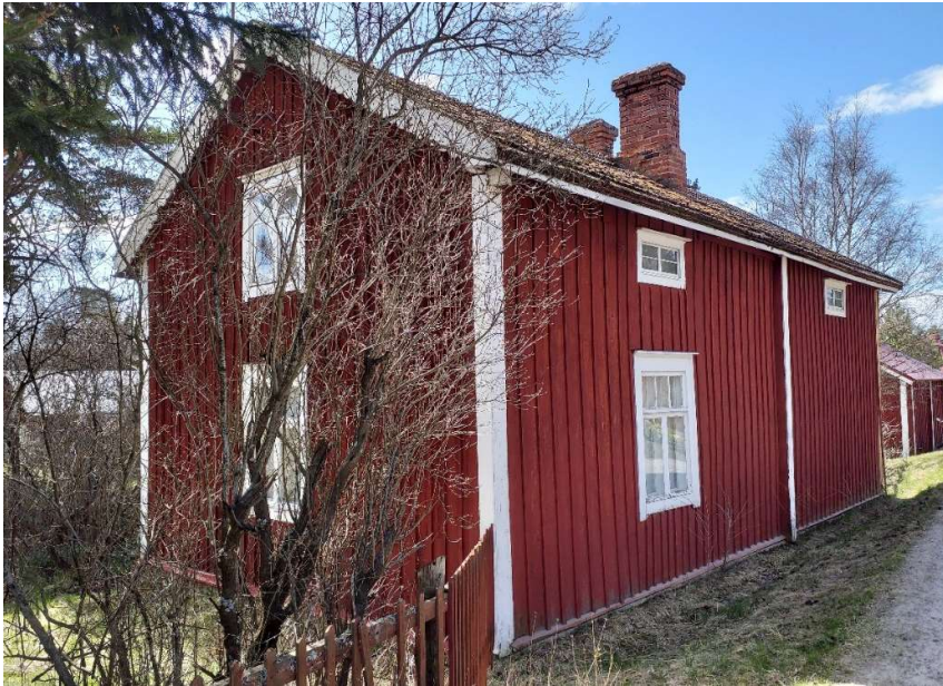
Bild 24 Bild av Skomakaris bostadsbyggnad som byggts under 1700-talet. Byggnaden ersatte då Lassila bostadsbyggnad. Byggnaden är skyddad i detaljplanen.
