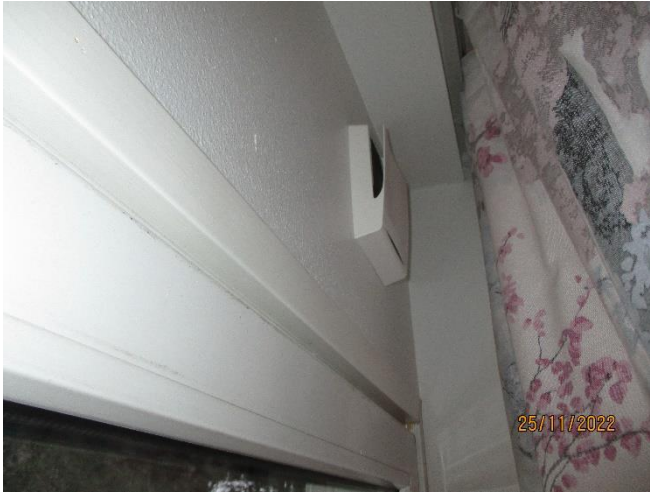
Bild 5. Friskluftsventil finns, även denna blockerades.
