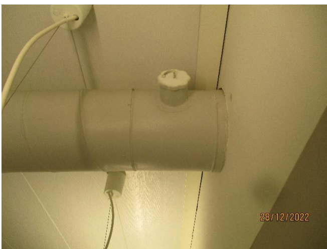
Bild 3. Ställvis räckte det med att strypa tilluften för att få önskat undertryck medan testet pågick. Efteråt justerades spjällen tillbaka till ursprungspositionen.
