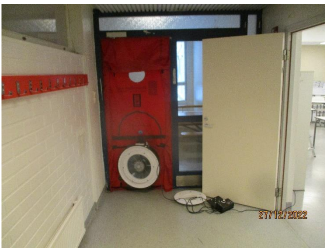
Bild 2. Ställvis användes extern fläkt för att uppnå jämnt undertryck på ca. -9 – -12 Pa.
