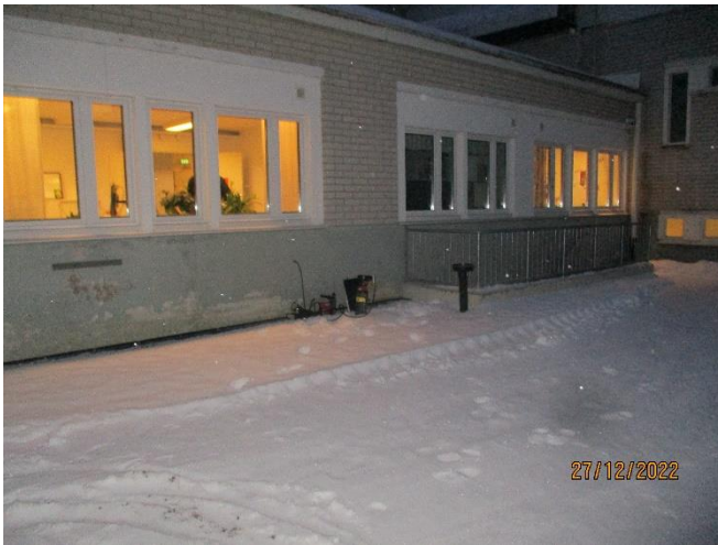
Bild 1. Gasen matades från utsidan i rektorsrummen.
