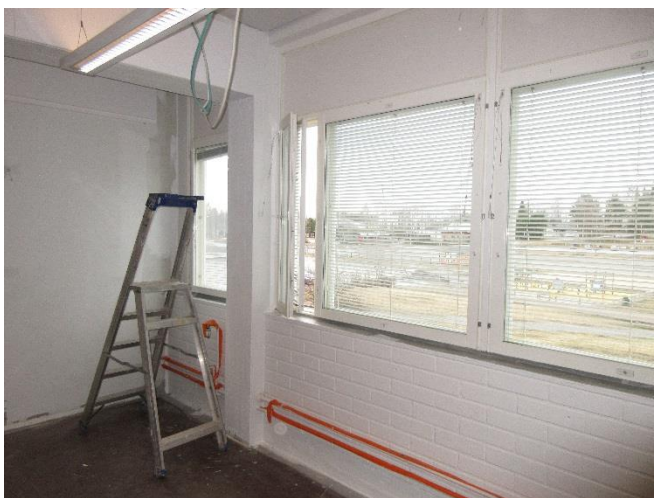
Bild 13. SÖ2. Täthetsreparation under arbete.
