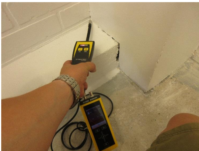
Bild 4. Läckageplatser söktes med givare.
