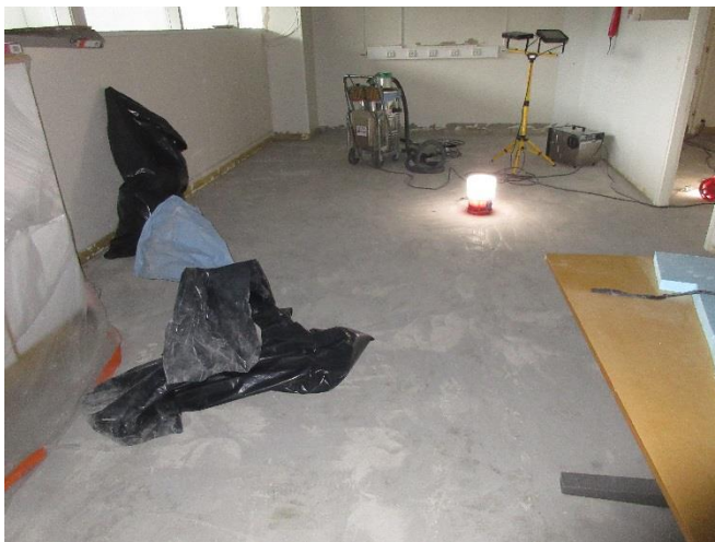
Bild 19. I biblioteket slipades golvet till ren betong.
