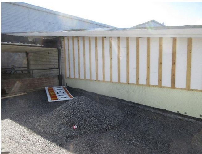
Bild 23. Väggen under återbyggnad.
