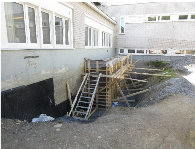
Bild 30. Trappan ner till krypgrunden utifrån under uppbyggnad.
