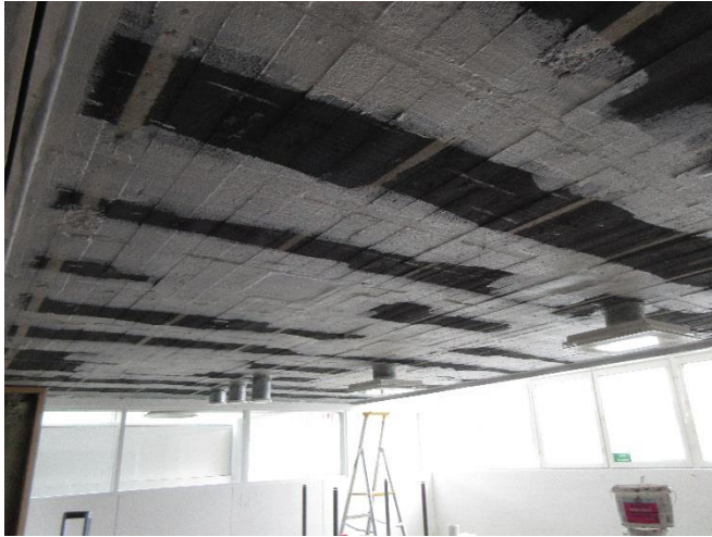
Bild 18. Täthetsreparation av tak i SÖ10.
