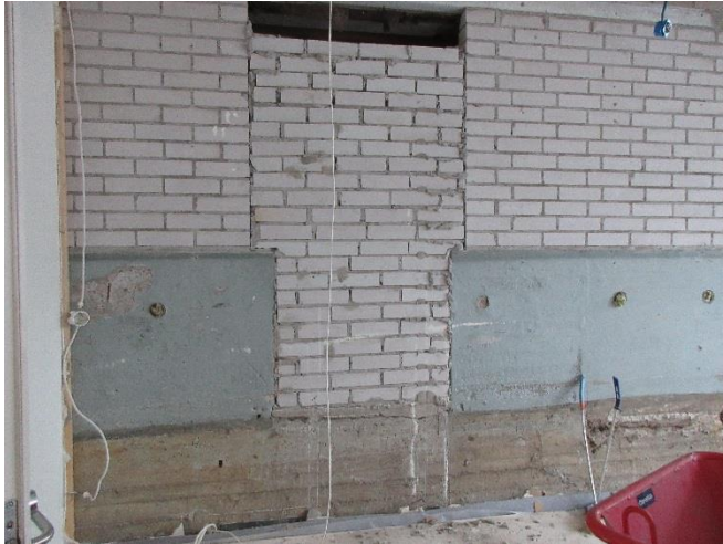
Bild 6. Väggen öppnades upp.
