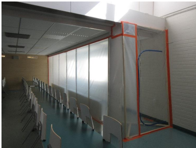
Bild 35. Matsalens yttervägg sektionerad. Väggen täthetsreparerades.
