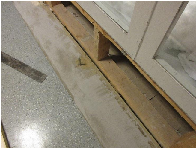
Bild 33. Otätheter från golvisoleringen till inomhusluften tätades.
