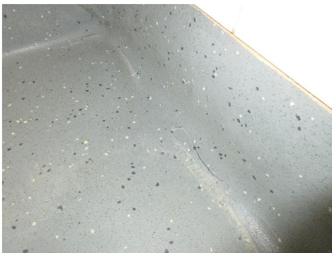
Bild 8. Snitt och sprickor vid uppviken konstaterades i plastmattan i duschutrymmena.
