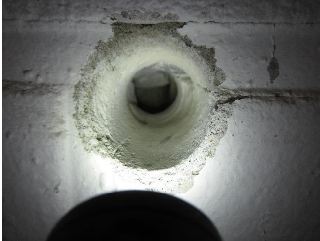
Bild 13. Den gamla ytterväggen är med tegel-ull-tegelkonstruktion
