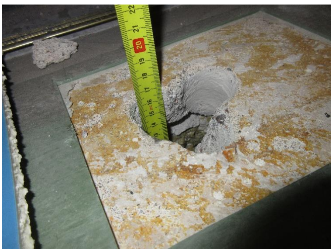
Bild 12. Total konstruktionstjocklek på ca 170mm.
