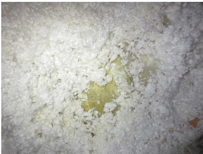
Bild 4. Under den nyare isoleringen finns en äldre glasullsisolering.
