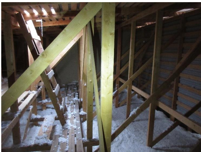
Bild 5. Luftrummet på mellantaket är högt.
