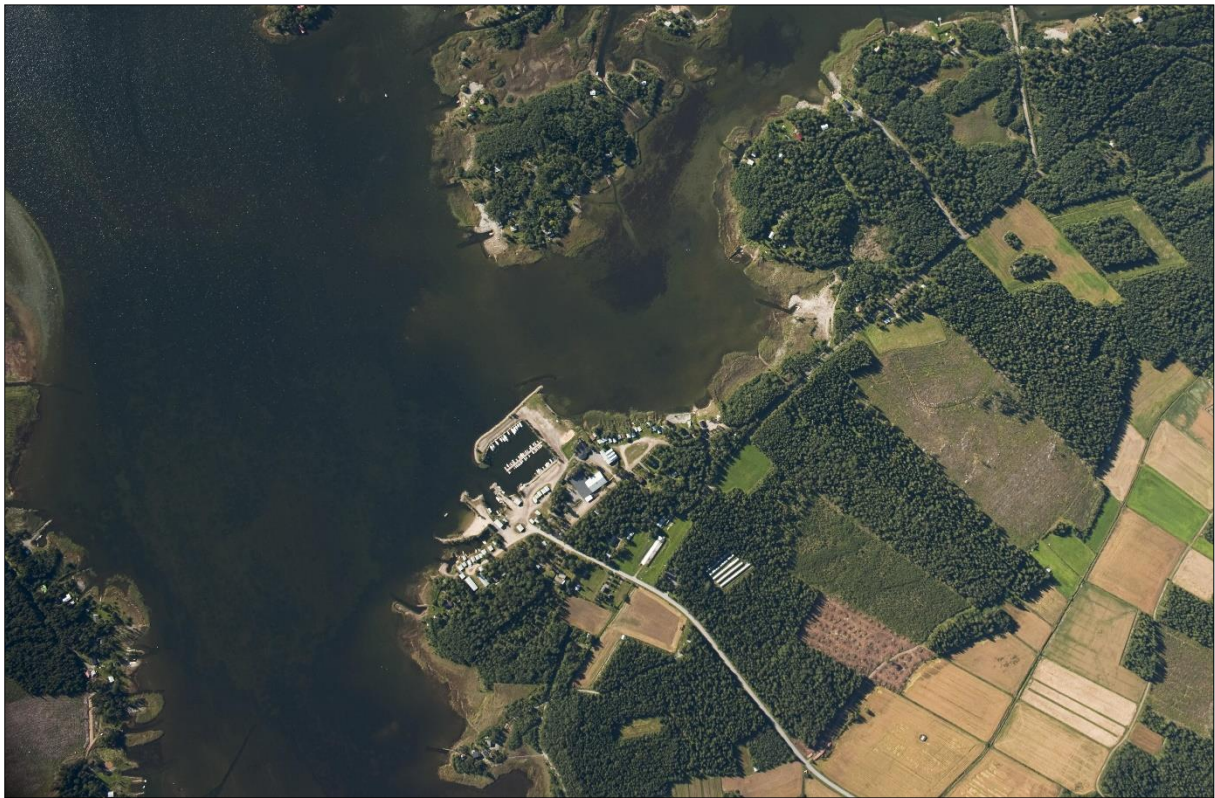
Figur 4: Flygfoto av Fagerö badstrand och dess näromgivning (våren 2009).
