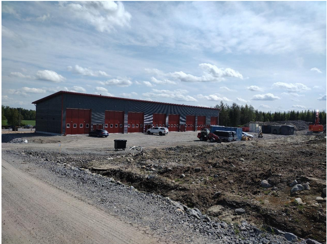
Kuva 6. Alueen uusi rakennus on varasto/varastohalli, jossa on kahdeksan erillistä tilaa.
