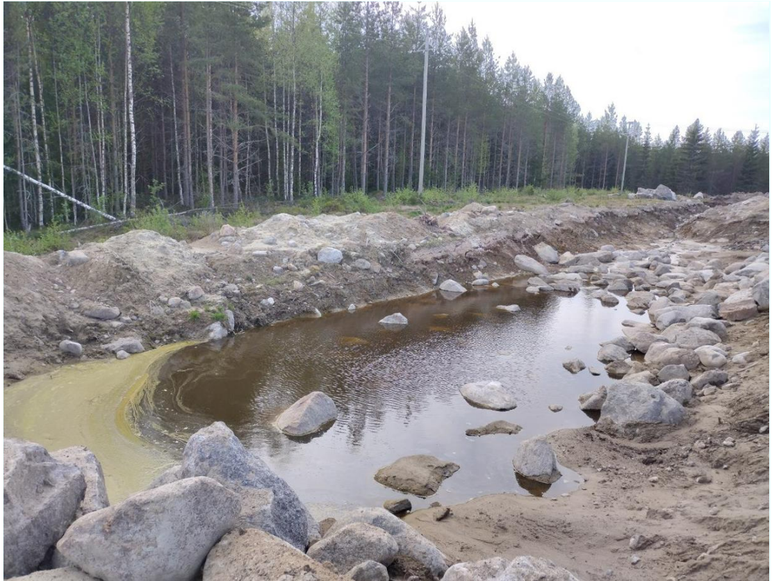
Kuva 11. Huleveden viivytysallas on rakenteilla kiinteistölle 3:181.
