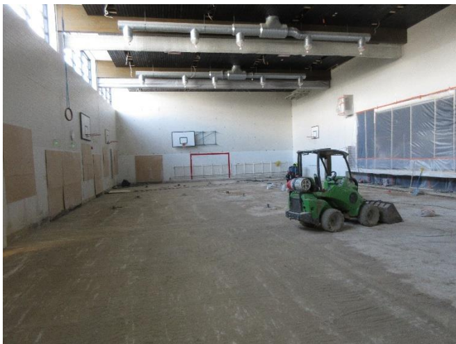
Bild 94. Ytslip, isolering och utjämningsanden avlägsnades i gymnastiksalen.
