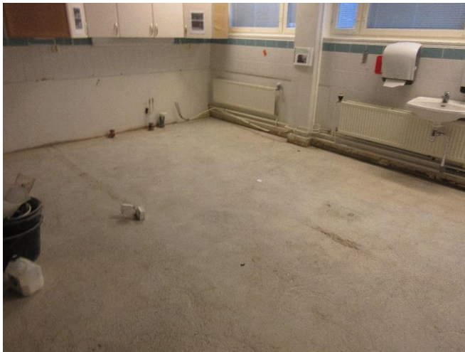
Bild 65. Överblick över utförd asbestsanering av golv, HU2.
