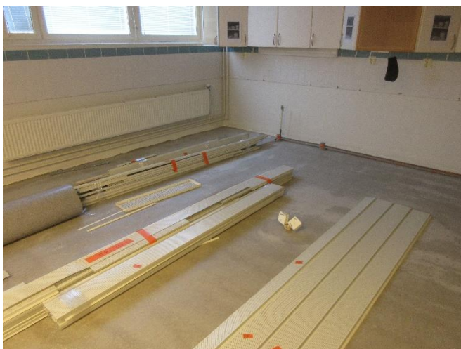
Bild 73. Innertak varit nedmonterat och mineralullsisolering har avlägsnats.
