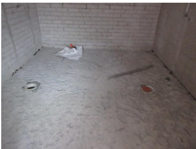
Bild 93. Isolering avlägsnades fram till ren betong.
