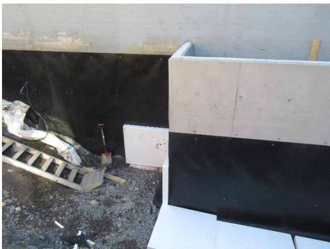
Bild 31. Ny grundmursskiva monterades på utsidan för att minimera fuktbelastningen.
