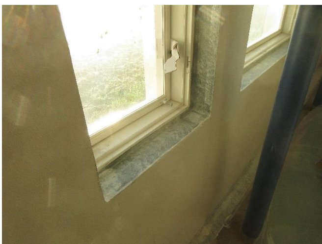
Bild 37. Täthetsreparering av fönsteranslutningar.
