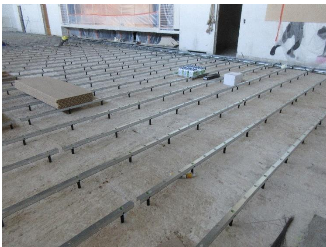
Bild 96. Montering av det ventilerade golvet under arbete i gymnastiksalen.
