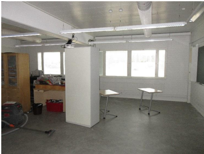
Bild 12. SÖ1. Färdigställnings av täthetsreparation.
