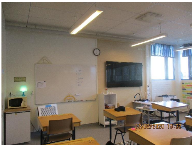
Bild 5. LM1, före renoveringen.
