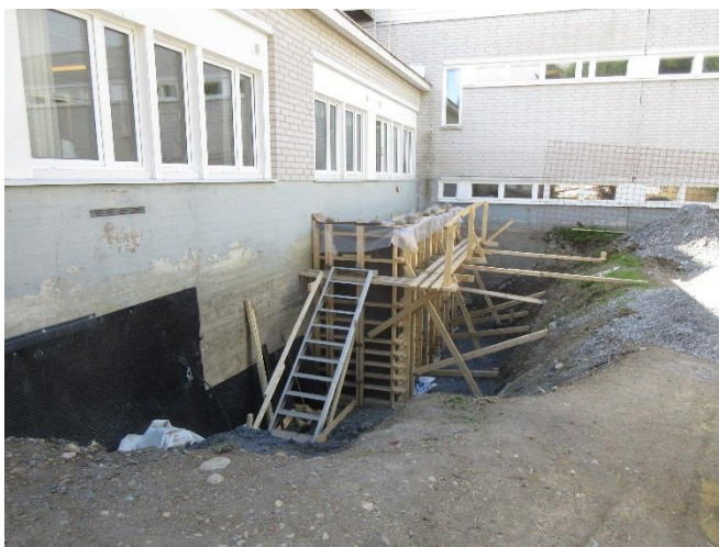
Bild 30. Trappan ner till krypgrunden utifrån under uppbyggnad.
