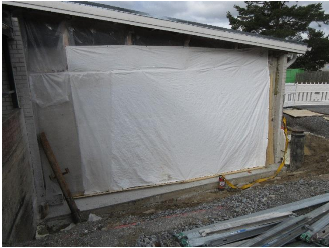
Bild 22. Väggen skyddad. Sluttning gjuten nertill. Ny dränering, beck i nedre kant samt ny isolering inväntas.
