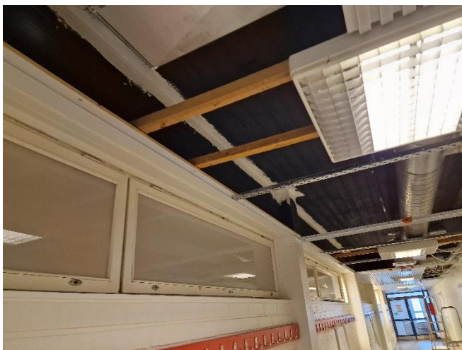
Bild 81. Även konstruktionsanslutningar tätades.
