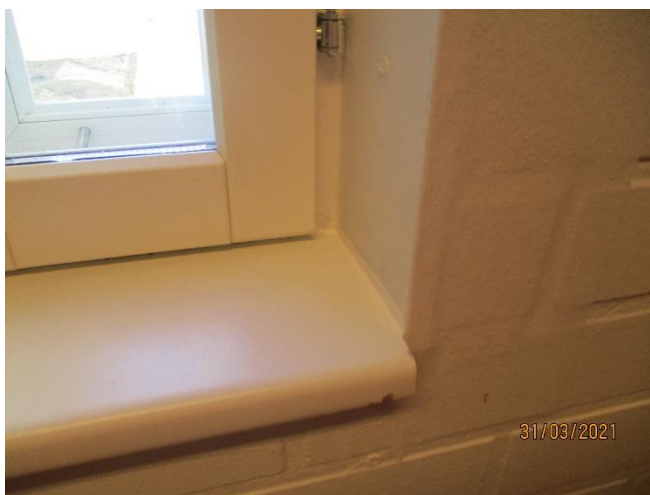
Bild 50. Fönstret hade återställts.
