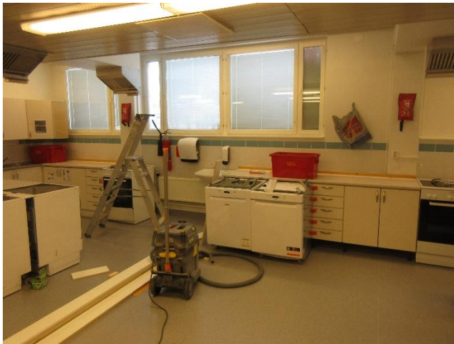
Bild 74. Återbyggnad under arbete.
