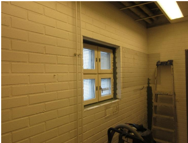
Bild 41. Tätning av fönsteranslutning.
