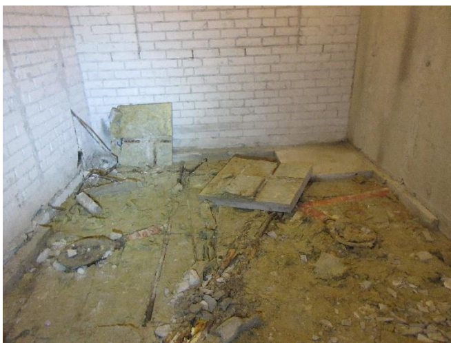
Bild 92. Ytslip avlägsnat i tvättutrymmen.
