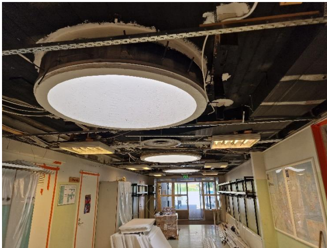
Bild 84. Genomföringar och konstruktionsanslutningar tätades.
