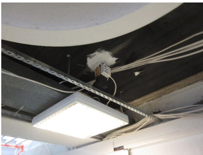
Bild 85. Genomföringar och konstruktionsanslutningar tätades.
