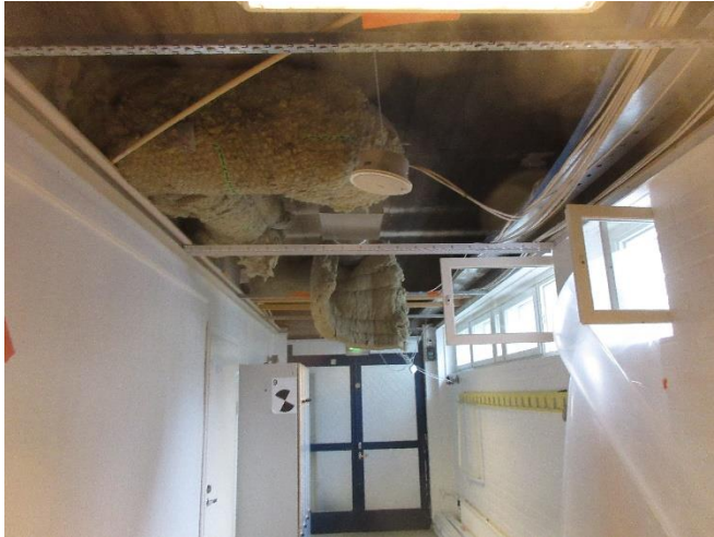
Bild 82. Synliga isoleringar med mineralfibrer i innertaket togs bort.
