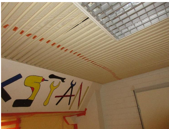
Bild 88. Nedsänkta tak med plåtskenor och mineralullsisolering plockades ner.
