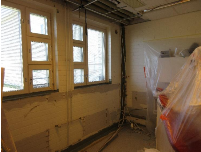
Bild 54. Bild från övervakningstillfälle 8.7.21. De sista utrymmena i skolhälsovården har täthetsreparerats men arbeten men att återmontera inredning o.s.v. är ej klart.
