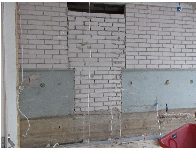
Bild 6. Väggen öppnades upp.
