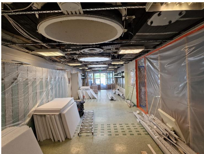
Bild 83. Överblick över reparationsarbeten i korridor.
