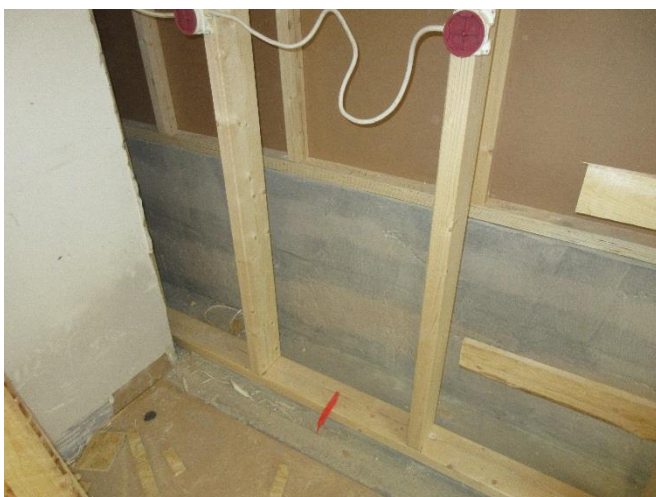
Bild 8. En ny lätt mellanvägg monterades istället för den gamla ytterväggen.
