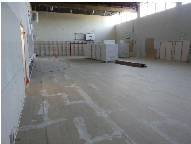
Bild 97. Spånskivsgolvet monterat i gymnastiksalen.
