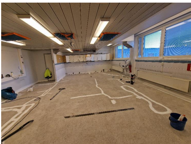
Bild 67. Tätningsarbetet gjort.
