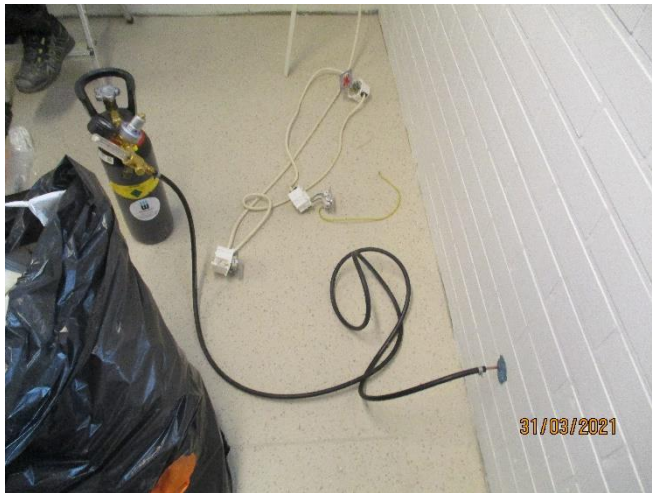
Bild 51. Plastmattan hade återställts. Spårgasen sattes in i ytterväggens nedre del.
