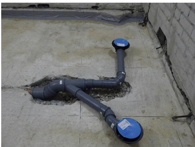
Bild 99. Återmontering av nya avlopp och golvbrunnar.
