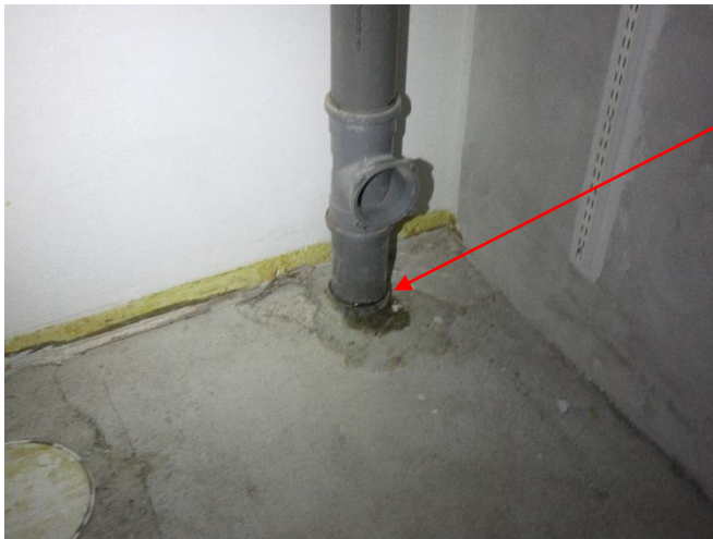
Bild 68. Läckande avloppsrörsanslutning.
