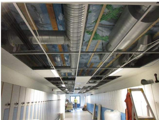
Bild 64. Taket plockades ner, rengöring utfördes och tätning av ångspärrsplasten utfördes.
