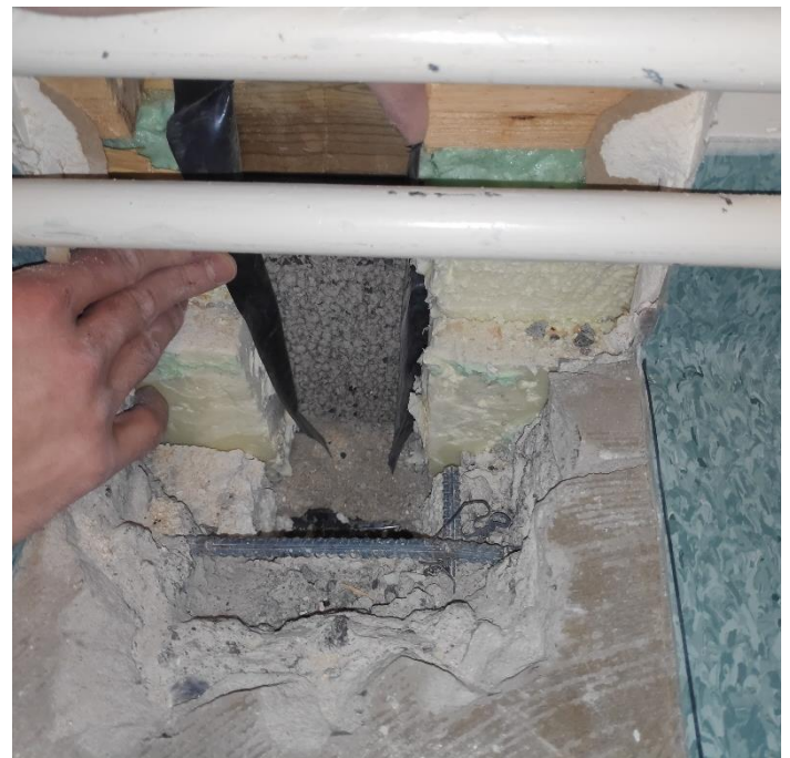
Bild 3-4. Skärning av ytterväggskonstruktionen samt bild genom konstruktionsöppning. Kontroll har utförts i samband med undersökningen av skolan, rapport daterad 23.5.2019
