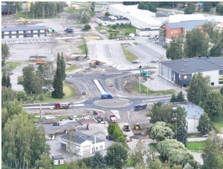
Bild 5. Rondellen under konstruktion.
