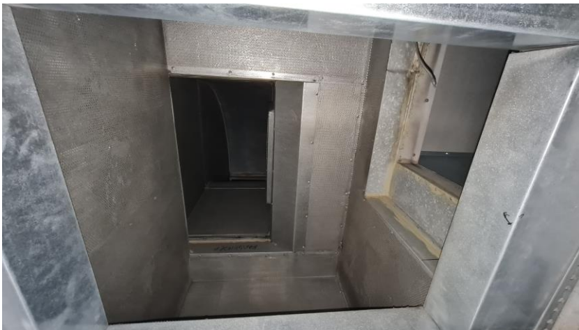
Bild 3 Tilluftskammaren Tk 1 Bild 3
