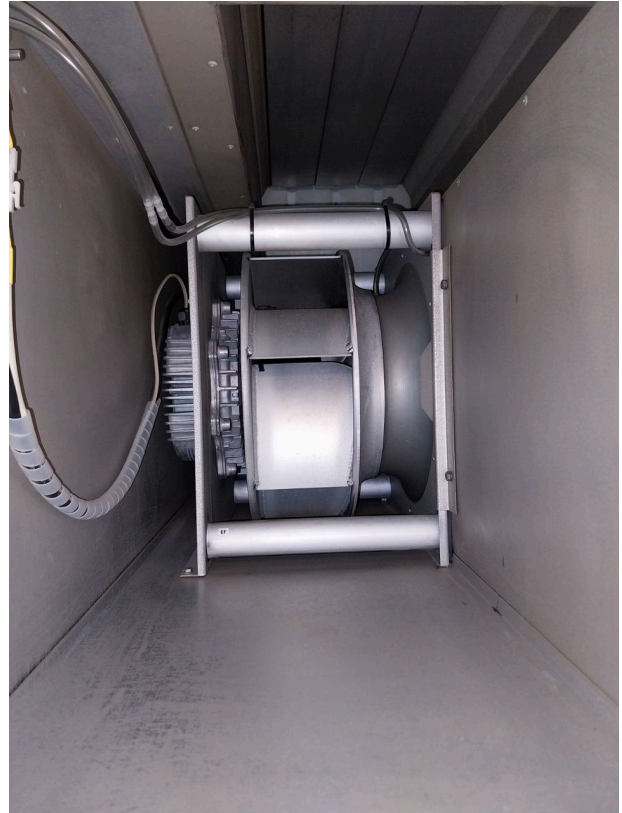
Poistopuhallinkammio jälkeen
