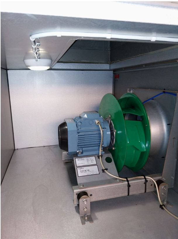
Poistopuhallin jälkeen
