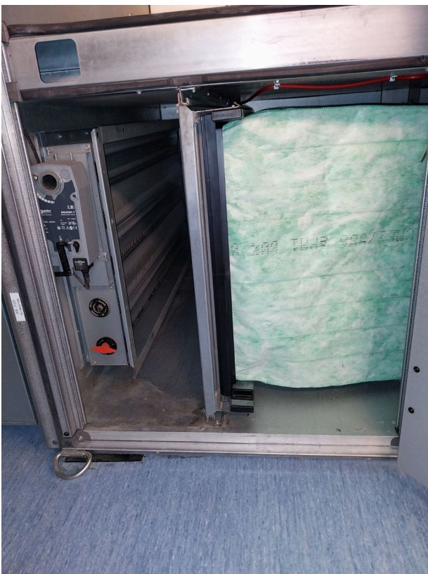
Tulosuodatinkammio jälkeen
