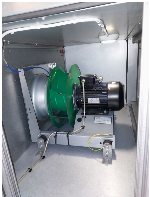
Tulopuhallin jälkeen
