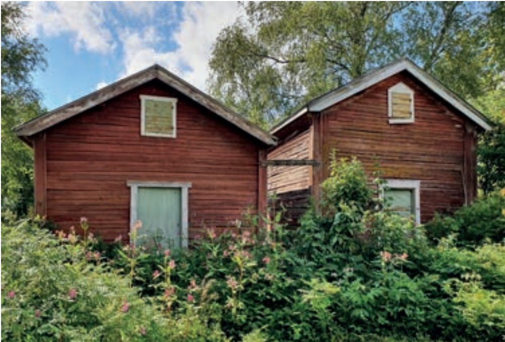
Uppe: På uthuset med körport (B) är byns brandklocka bevarad i en stapel i norra gaveln Till vänster: de välbevarade timrade bodarna skärmar av gården mot väster. Luckomfattningen med fronton är typiskt för empirestilen
