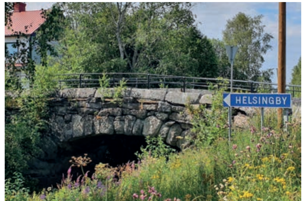
Uppe till höger: Toby stenbrons södra brospann med dubbla valv, sedd från Holmen. Uppe till vänster: bron är kallmurad i granit. På bild dess norra brospann med ett valv. Till vänster anas den gamla bybutiken, numera i bruk som bostad (objekt 13, Toby).
