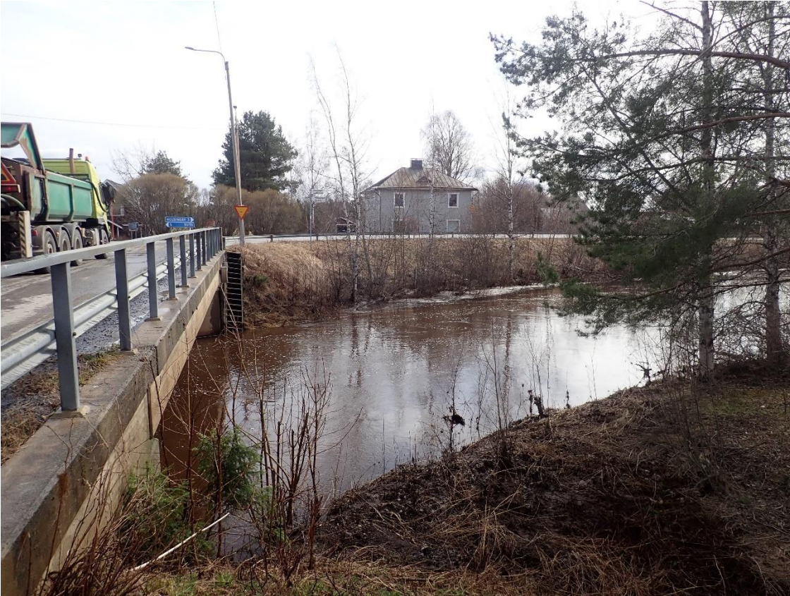
Bild 15. Västra sidan av Karkmo bro. Söderut.
