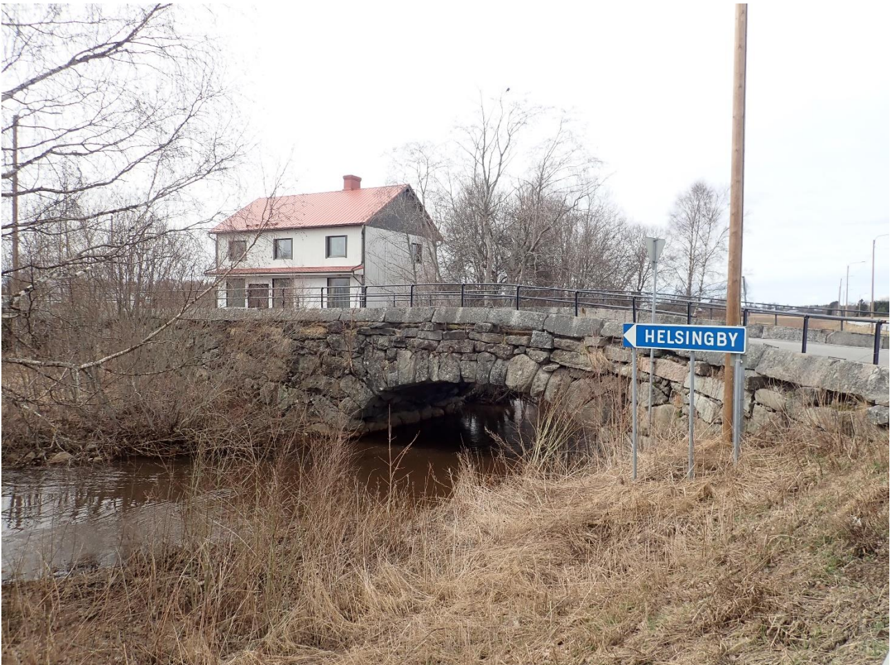
Bild 1. Toby stenbro som är byggd 1781 i den västra delen av projektområdet. Mot väst-sydväst.
