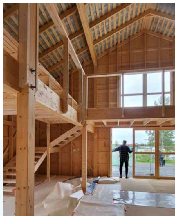
Sisäkuva rakennusajalta. KUVA: MONA BRITWIN
