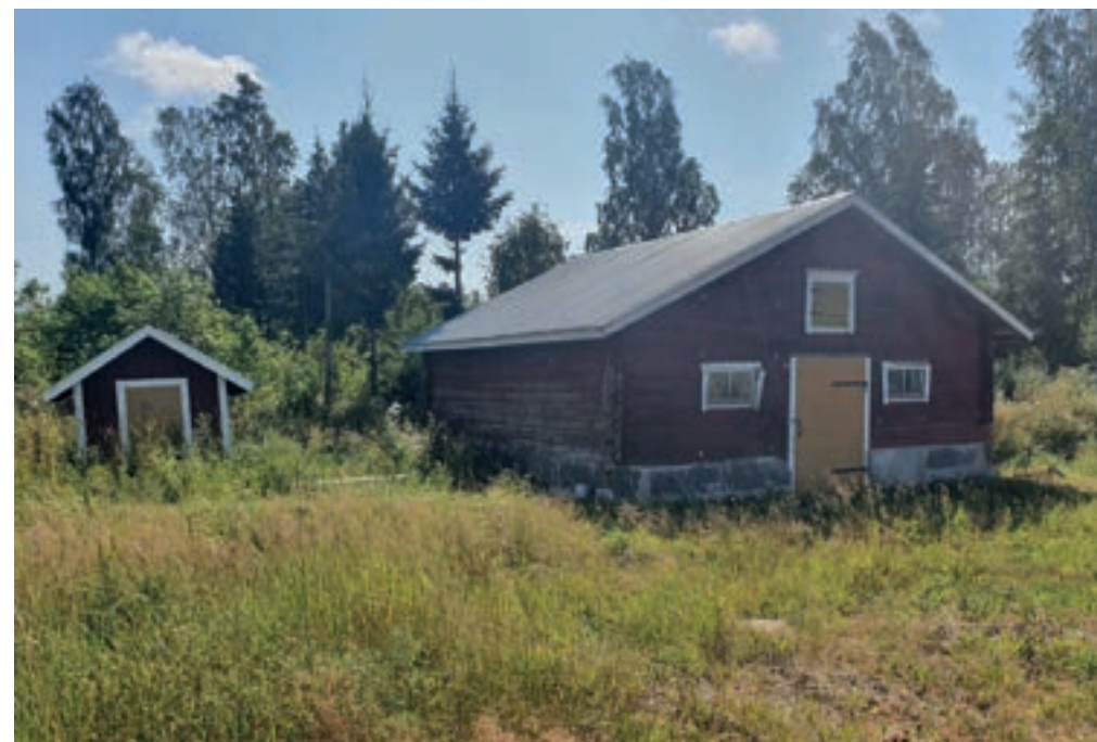
Ylhäällä vasemmalla: L-mallisen ulkorakennuksen (B) takana näkyy moderni traktorihalli. Ylhäällä oikealla: Ulkorakennuksen B) sisäkulmassa on ajoportti ja laitimmaisena vasemmalla on ulkovessa. Pihalta katsottuna. Ohessa oikealla: Navetta (D) korkealla kivijalallaan, pohjoisesta katsottuna. Vasemmalla vielä yksi pieni varistorakennus.
