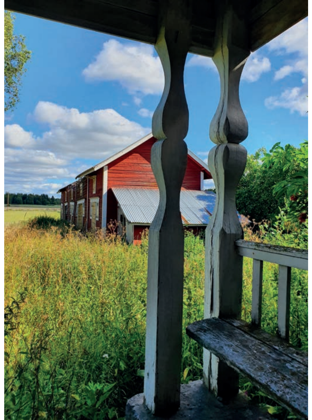
Yllä: Talonpoikaistalossa (A) on paikallisesti tyypillinen avokuisti, jonka arkkitehtuuri on korkealaatuista harmonisten suhteiden ja huolellisen veistotyön ansioista. Ohessa oikealla: Näkymä kuistilta kylätielle ja veistettyjen tolppien muotojuhlaa. Ulkorakennus (B) kuvassa keskellä.
