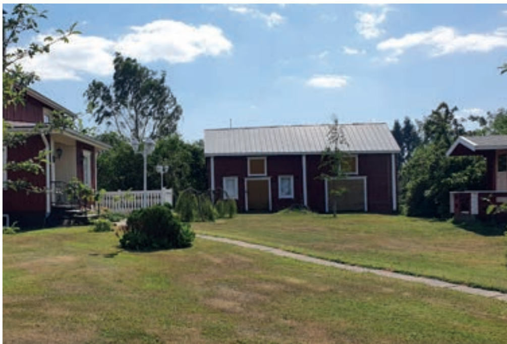
Yllä: Tilalla on näkyvä sijainti maisemassa ja sillä on tärkeä rooli kylämaisemassa. Oheessa vasemmalla: Kolmiosainen makasiini (C) rajaa pihaa etelään ja muodostaa kolmelta sivulta umpeen rakennetun perinteisen pihapiirin.
