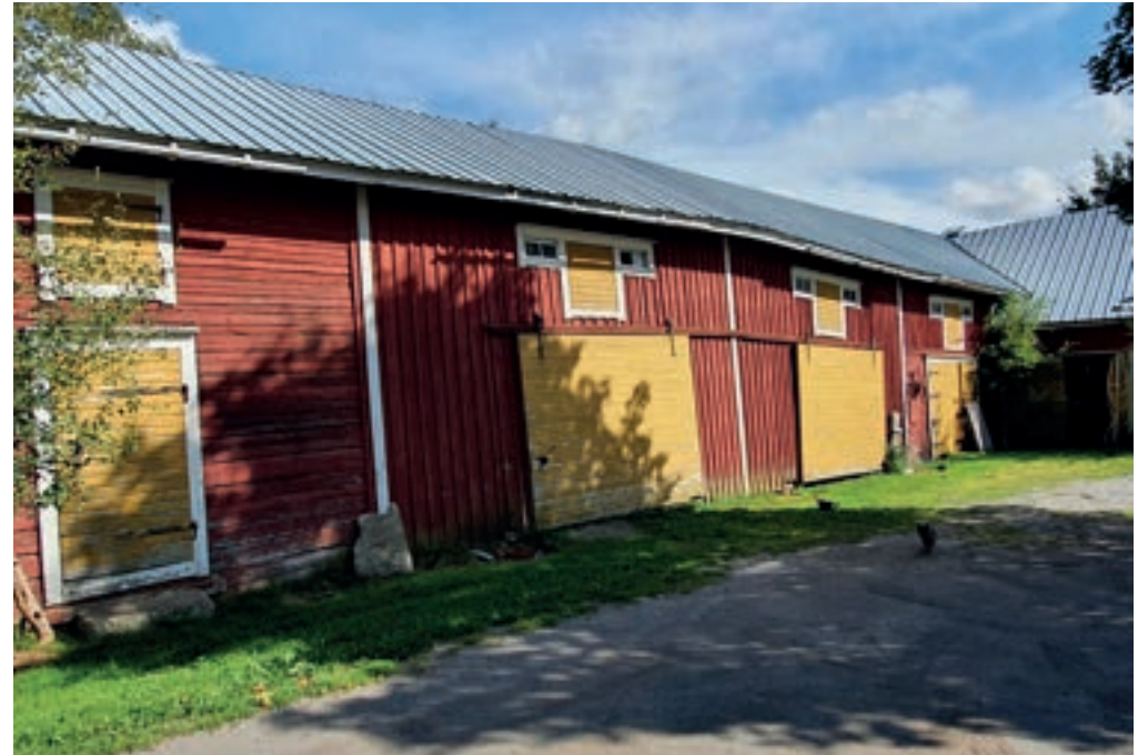
Ylhäällä vasemmalla: Talonpoikaistalon (A) pihan puolella on uudistettu 1960-luvun laajennus. Ylhäällä oikealla: Ulkorakennus (D) rajaa pihaa peltomaiseman suuntaan. Ohessa oikealla: Ulkorakennus (C) on osittain hirsirakenteinen ja osittain rankarunkoinen ja sitä on varovasti sovitettu uusiin tarpeisiin.
