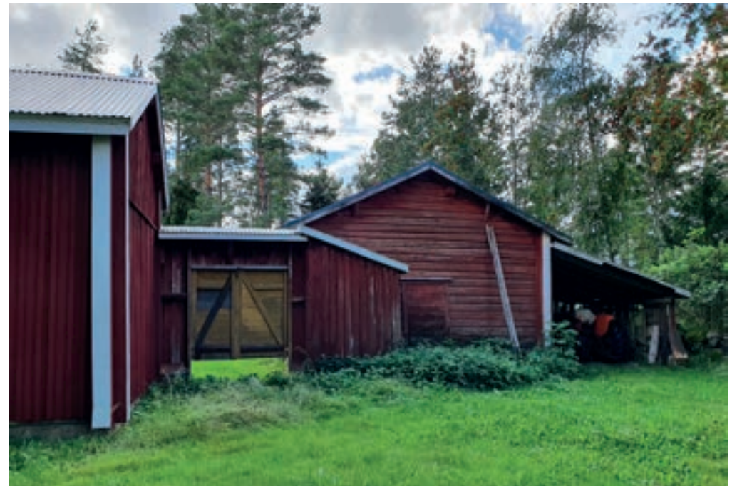
Ylhäällä vasemmalla: Ulkorakennuksen (C) julkisivusommittelu on paikallisesti tyypillinen. Ylhäällä oikealla: Ulkorakennukset rajaavat pihaa kahteen suuntaan. Ohessa oikealla: Ulkorakennusten välinen kulma on rakennettu umpeen ja siinä on pihasta pois johtava lautaportti.
