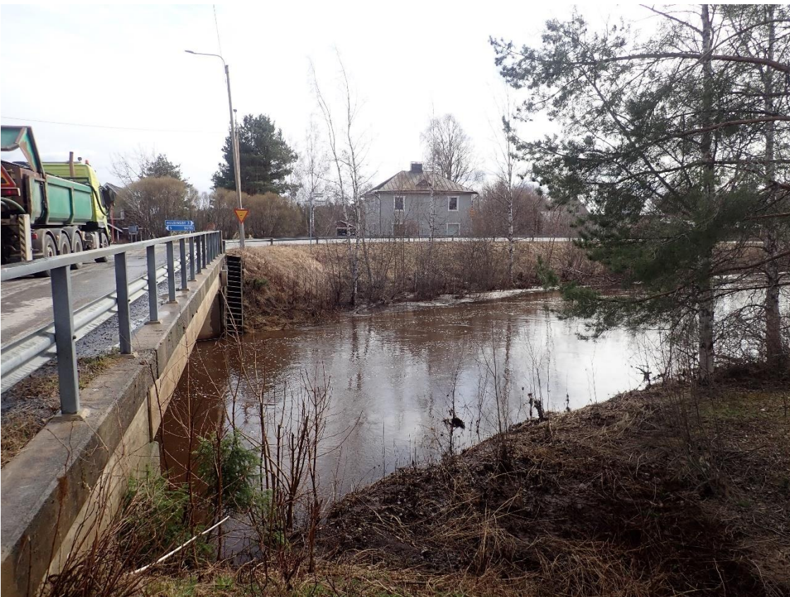
Kuva 15. Karkkimalan sillan länsipuolta. Etelään.
