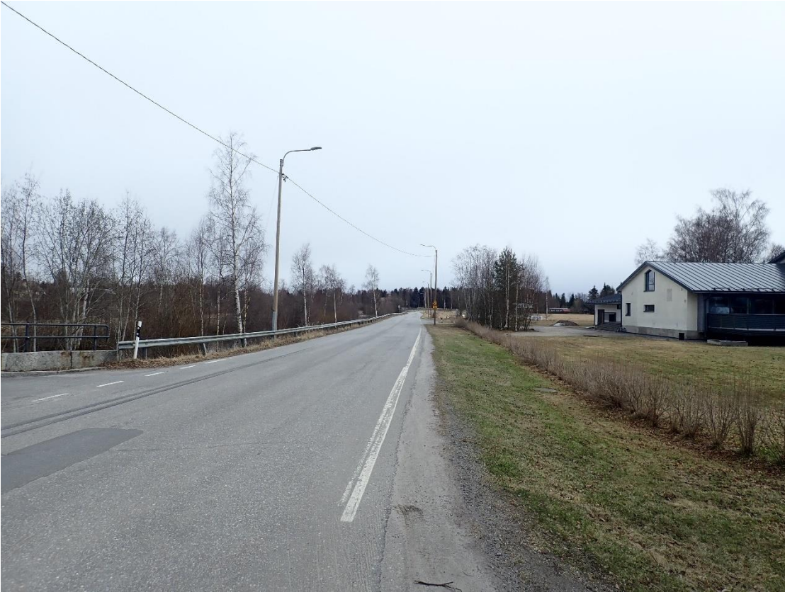
Kuva 16. Nykyinen Karkkimalantie Helsingbyn kohdalla. Samalla kohtaa on kulkenut keskiaikainen Rantatie. Itään.
