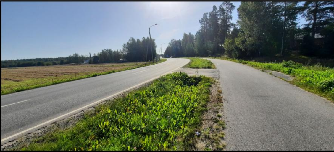
Kuva 13. Karperöntien ja Bölenkaarteen liittymäkohta etelän suuntaan katsottuna (VE1).
