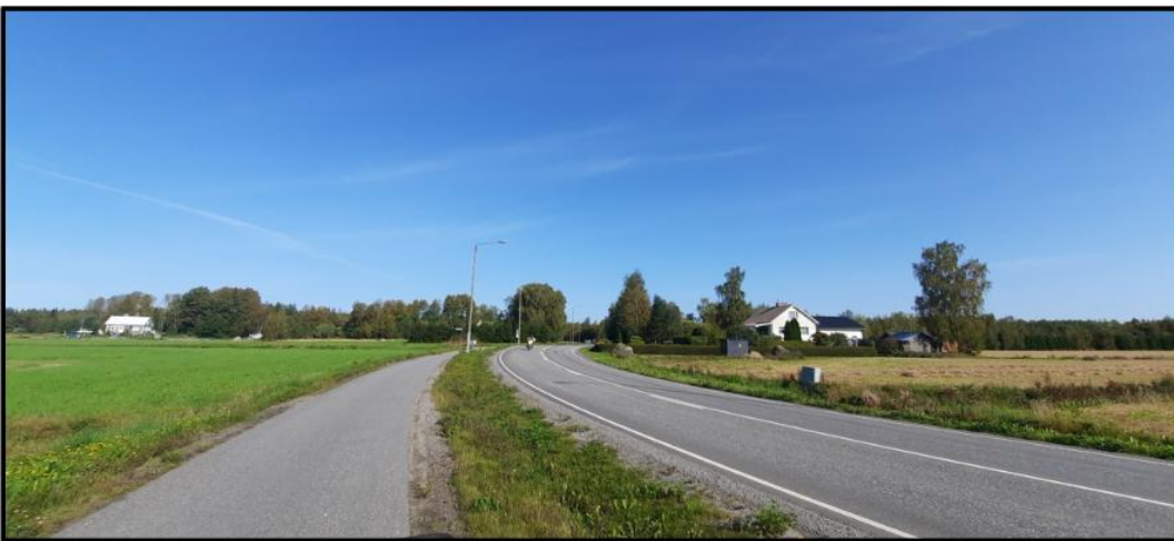
Kuva 12. Karperöntien ja Bölenkaarteen liittymäkohta pohjoiseen katsottuna (VE1).
