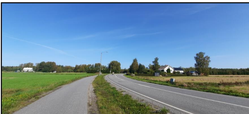
Bild 12. Sikten norrut från anslutningen vid Karperövägen och Bölesvängen (ALT1).
