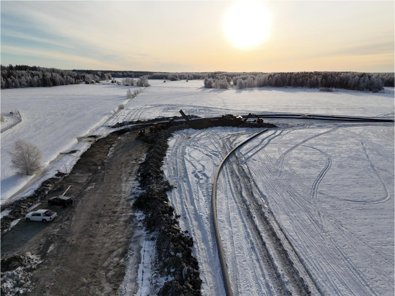
Kuva 4. Hulevesijohdon rakentaminen käynnissä Vattvikenin pumppaamolta tammikuussa 2024.
