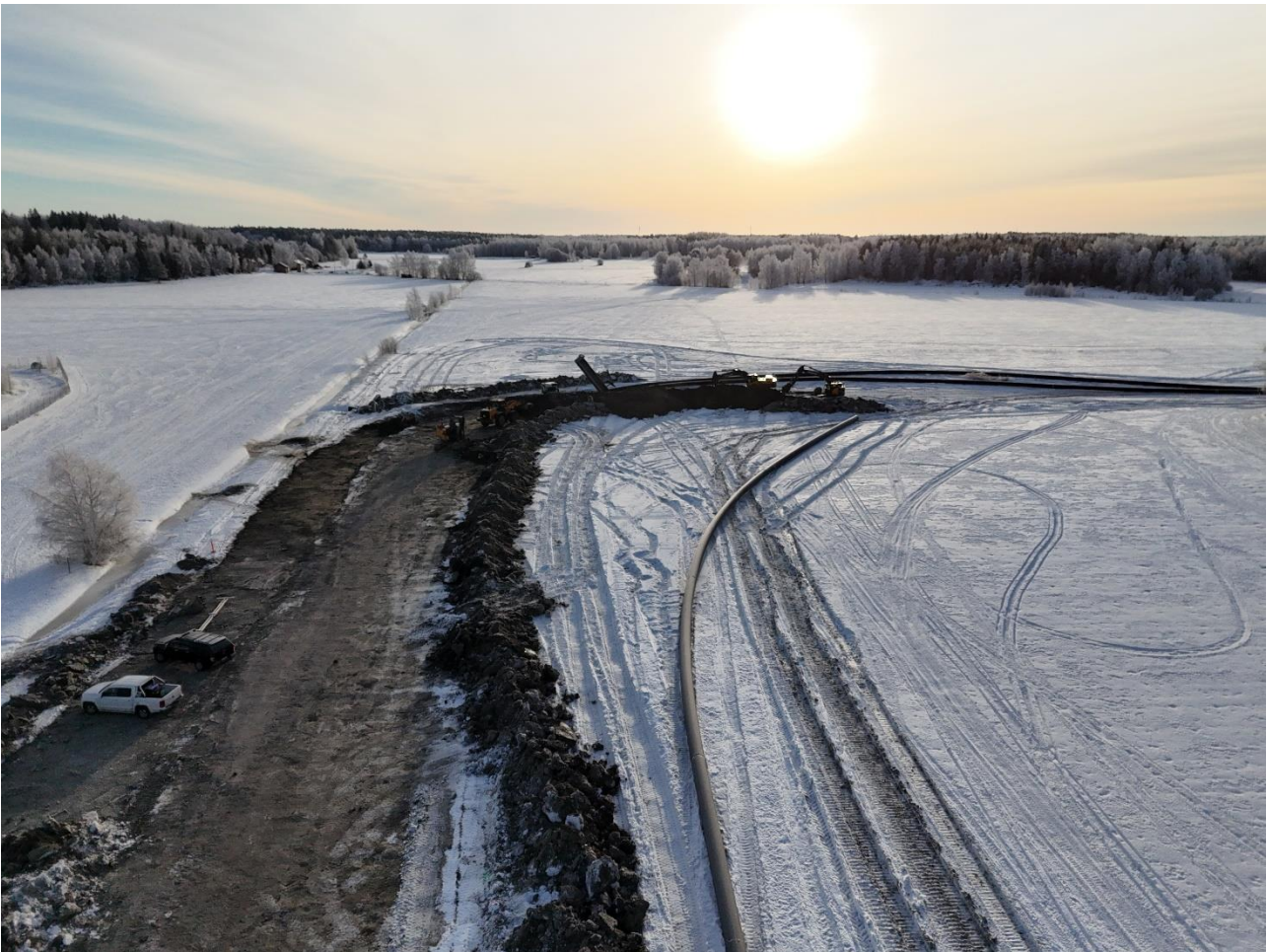
Bild 4. Dagvattenledning byggs från pumpstationen i Vattvik januari 2024.
