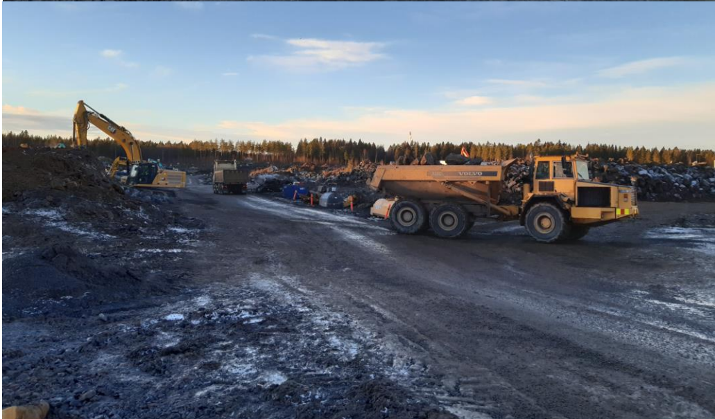
Bild 4–5. Vy mot tomt 1 i kvarter 24, där byggandet av Hitachi Energy Finlands produktions- och teknologicampus har påbörjats.
