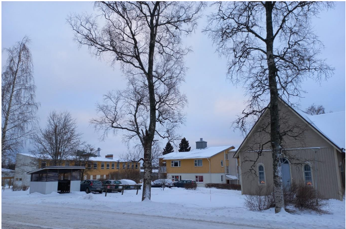
Kuva 4. Kortteli 14a; kerrostalotontti (AK) keskellä ja koulutontin (YO-1) vanha rakennus vasemmalla ja seurakunnallinen rakennus oikealla. Kuvattu Sulvantieltä.
