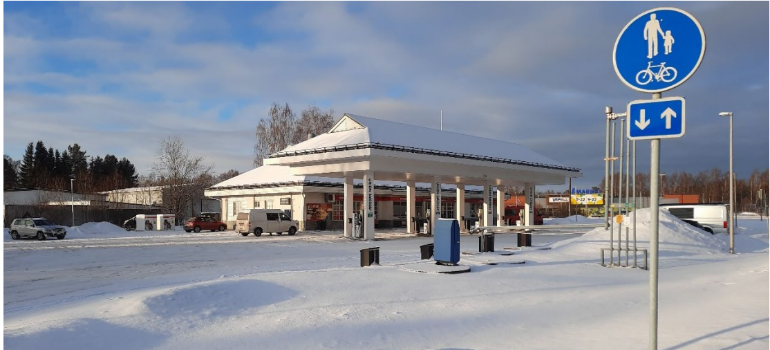
Kuva 6. Kuva kaava-alueen eteläosassa olevasta huoltoasemasta. Kuva on otettu Vesilaitoksentieltä lännen suuntaan.
