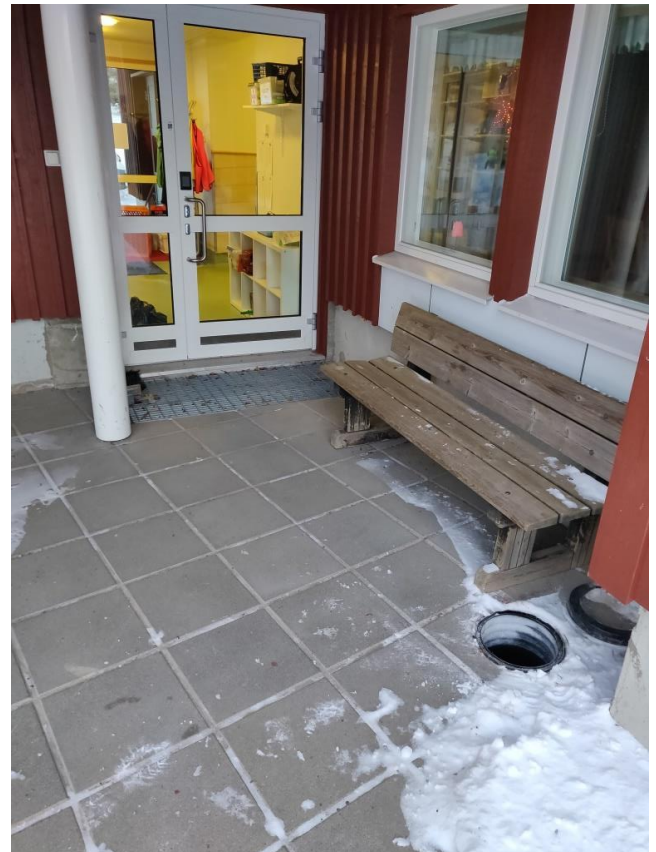
4.1.2. Fastigheten har blindsockelkonstruktion
