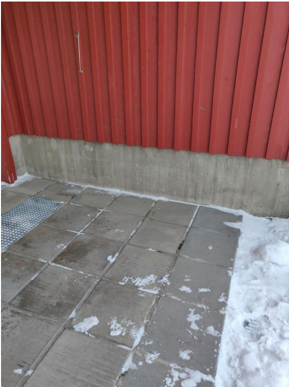
4.1.3. Fastigheten står på en ren betongsockel. Större brister i sockeln, utvändigt, konstaterades inte. Ingen sockelmatta är monterad
