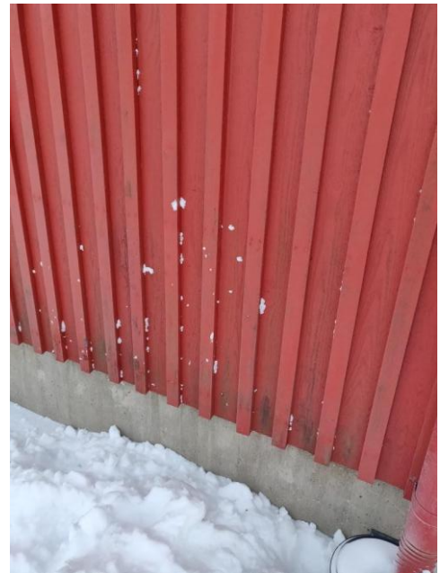
4.2.4. Fasaden har mindre områden med smuts men är överlag i gott skick
