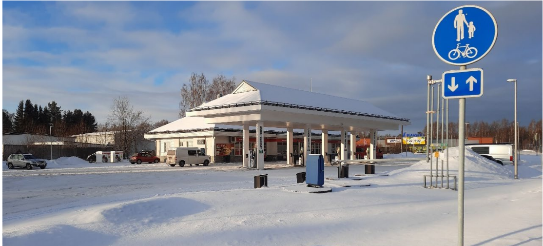
Bild 6. Fotografi av bränslestationen i planområdets södra del. Bilden är tagen från Vattentagsvägen i västlig riktning.
