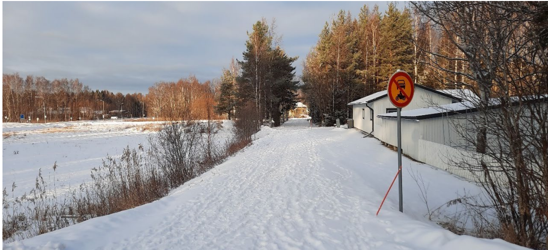
Bild 8. Fotografi av Prostöstigen och intilliggande bebyggelse. Bilden är tagen från Korsholmsvägen i nordvästlig riktning.
