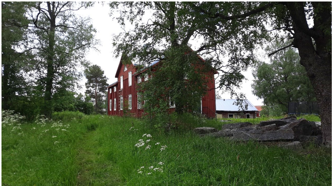
Kuva 7. Valokuva kaava-alueella sijaitsevasta asuinrakennuksesta.
