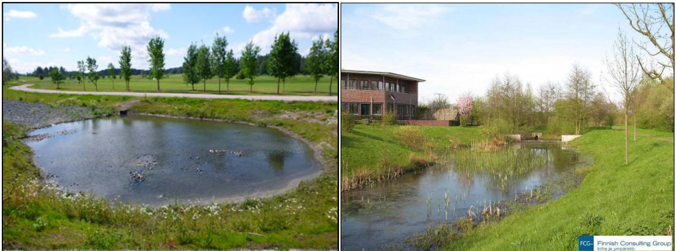
Bild 12. Exempel på en bassängliknande infiltrations-/fördröjningssänka i Esbo samt ett våtmarksliknande fördröjningsområde i Hannover. 6
