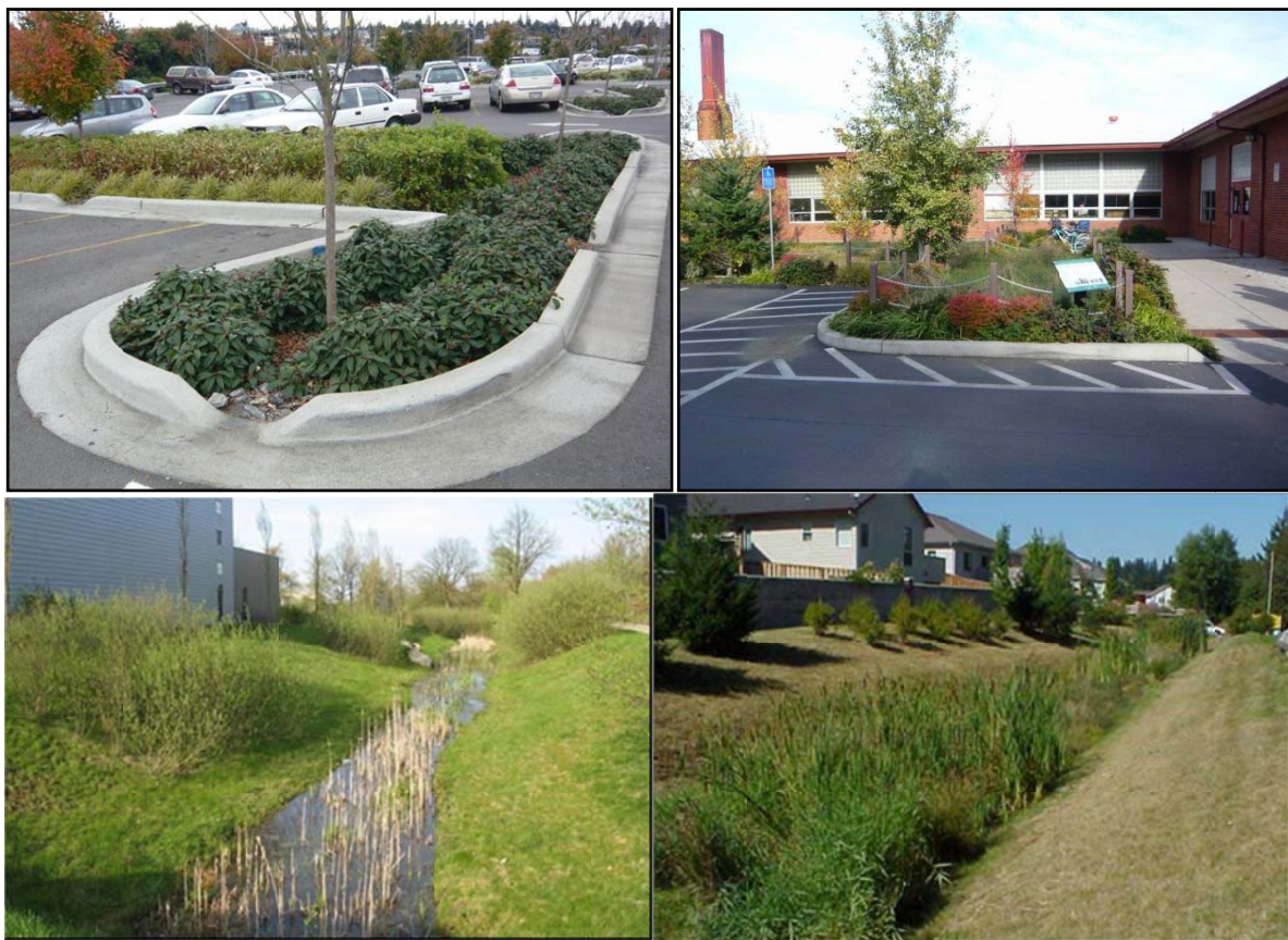
Bild 9. Utnyttjande av gröna sänkor för fördröjning och infiltrering av dagvatten. Den övre vänstra bilden är från Seattle, den högra från Hannover 6 . Den högra bilden nedan är från Portland. 8
