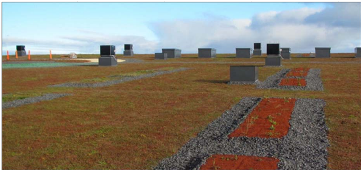
Bild 5. Finlands största och nordligaste gröna tak blev färdigt i Uleåborg 2012. Moss-fetknoppstaket på sorteringsanläggningen LARE vid avfallscentralen i Rusko har en areal på 3600 m 2 . 5
