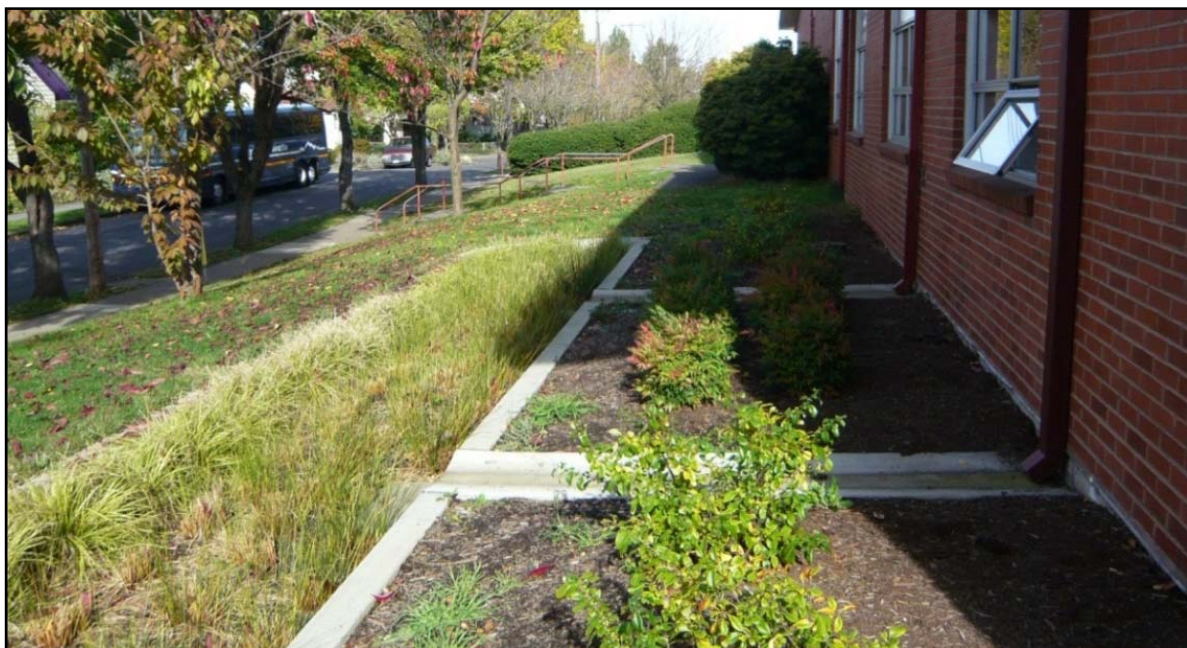
Bild 7. Exempel på en grönzon som fördröjer takvatten. Vertikalt i mitten går ett litet dike som är avsett för att kontrollera bortledningen. I exemplet avleds dagvattnet från stuprören längs en betongränna till grönzonen som finns tillräckligt långt från byggnaden. Bilden är från Portland. I Finland har man oftast inte jord ända in vid väggen, utan i stället grus eller kross. 6
