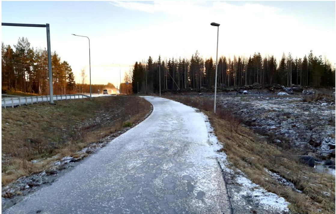
Kuva 7. Porintien–Kyykäärmeentien liittymästä etelän suuntaan johtava kevyen liikenteen väylä.
