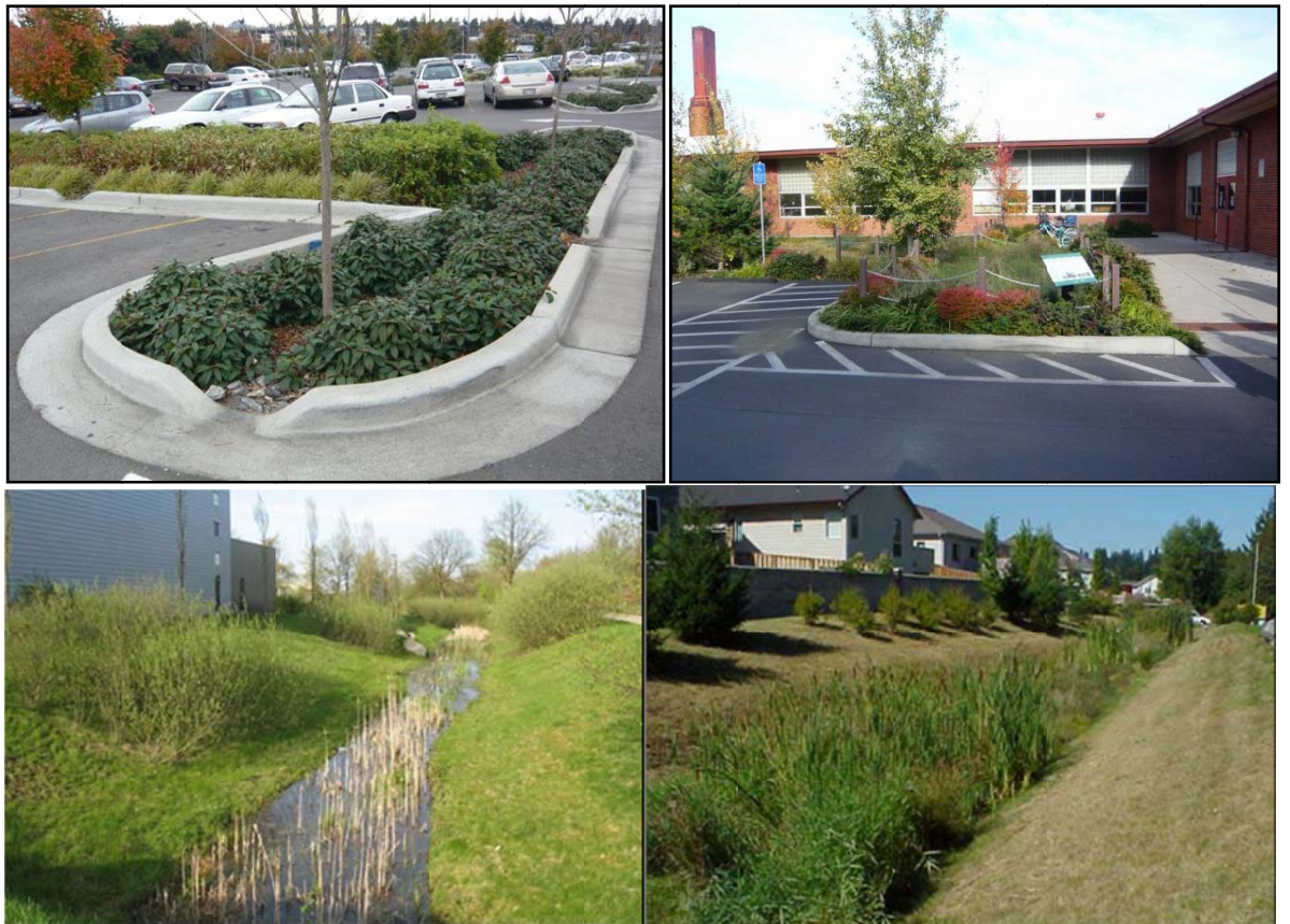
Kuva 9. Viherpainanteiden hyödyntämistä hulevesien viivytyksessä ja imeyttämisessä. Vasen yläkuva on Seattlestä, oikea yläkuva Seattlestä ja vasen alakuva Hannoverista 6 . Oikea alakuva on Portlandista. 8
