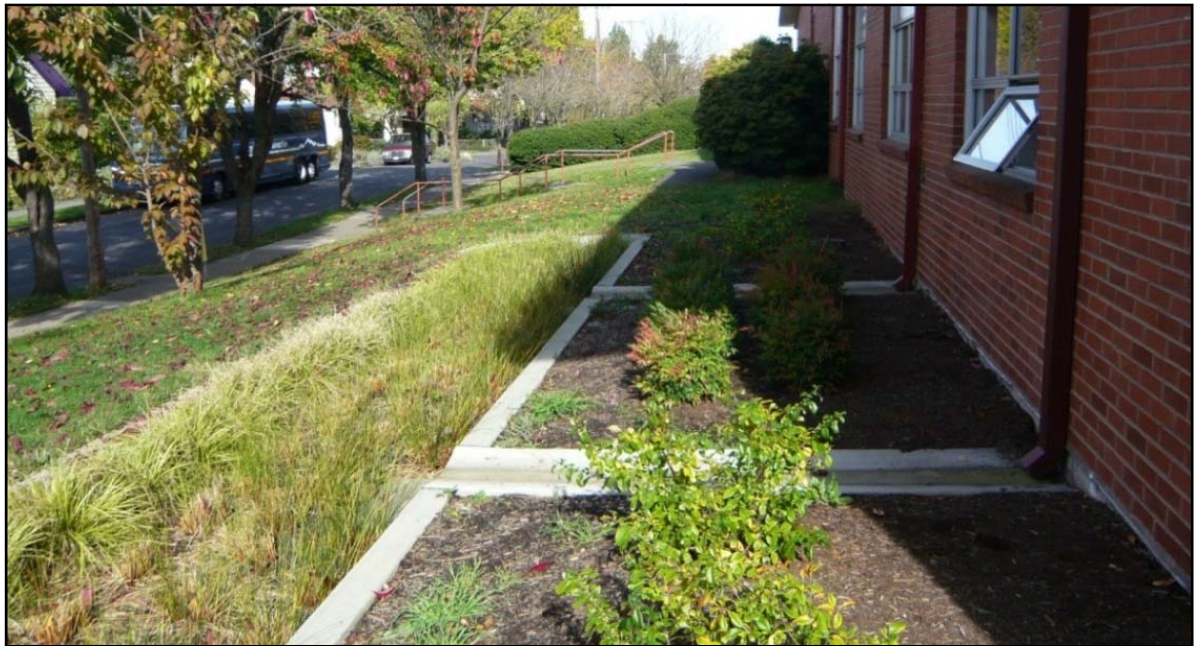
Kuva 7. Esimerkki kattovesiä hidastavasta viherkaistaleesta, jonka keskellä pituussuunnassa kulkee pieni, vesien hallittuun johtamiseen tarkoitettu oja. Esimerkissä hulevedet johdetaan syksytorvista betonista kourua myöden viherkaistaleelle, joka sijaitsee riittävän etäällä rakennuksesta. Kuva on Portlandista. Suomessa rakennuksen seinustalle ei yleensä uloteta multausta, vaan tilalla on soraa tai mursketta. 6
