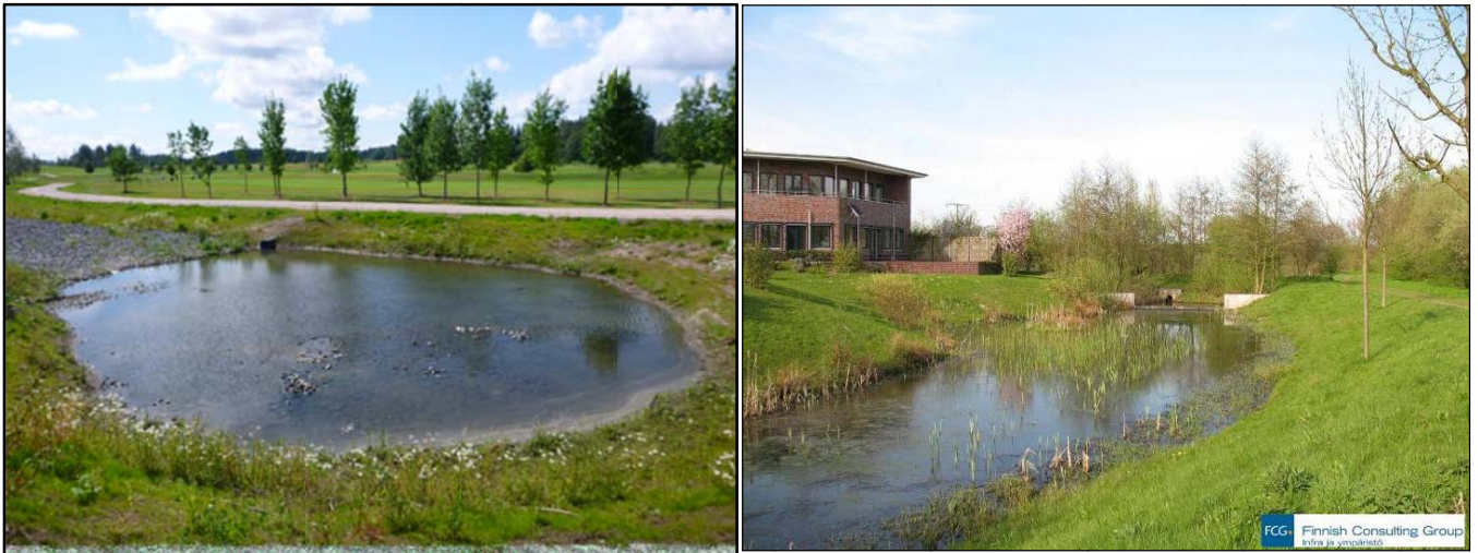
Kuva 12. Esimerkki allasmaisesta imeytys/viivytyspainanteesta Espoossa sekä kosteikkomaisesta viivytysalueesta Hannoverissa. 6
