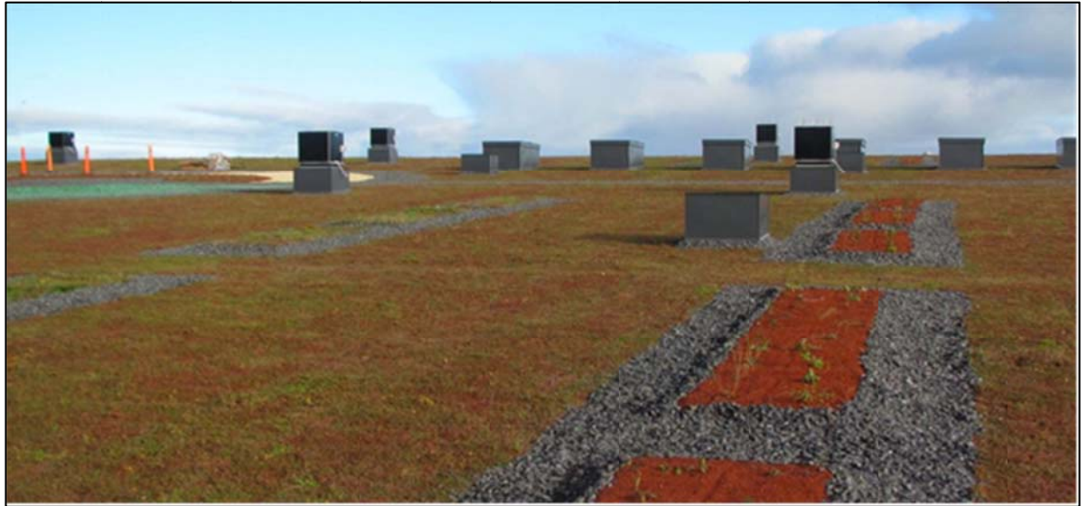
Kuva 5. Suomen suurin ja pohjoisin viherkatto valmistui Ouluun vuonna 2012. Ruskon Jätekeskuksen lajitteluareenan (LARE) sammal-maksaruohokaton pinta-ala on 3600 m 2 . 5
