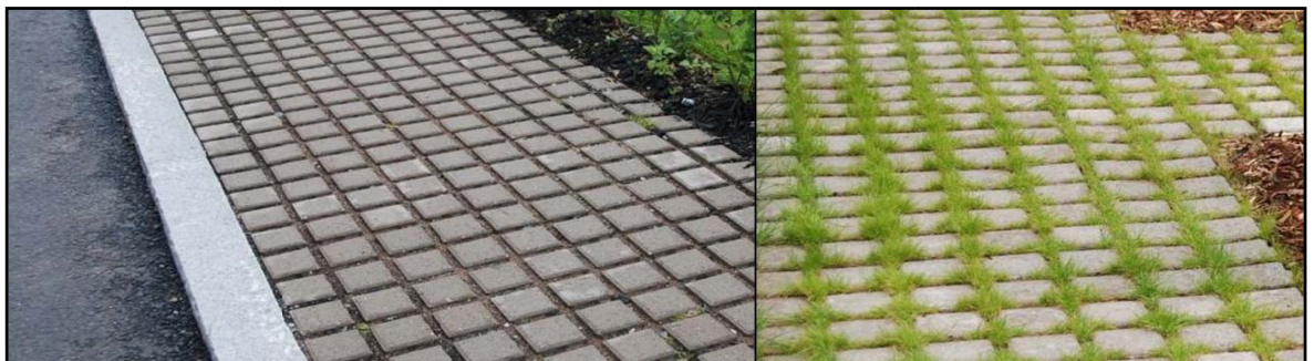
Kuva 6. Esimerkkejä läpäisevien päällysteiden käytöstä. Tampere, Vuores. 6
