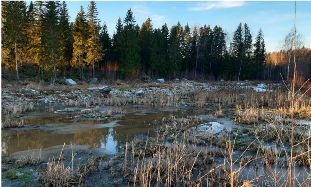
Bild 9. Dagvattenbassäng, vilken har byggts år 2021 mellan kvartersområde 20 och 21 inom skyddsgrönområde (EV-3).
