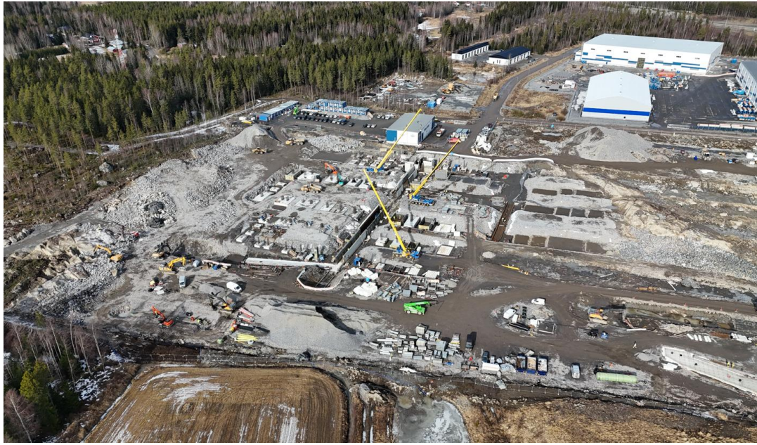
Bild 20. Byggnation på tomt 1 i kvarter 24, 03/2025.
