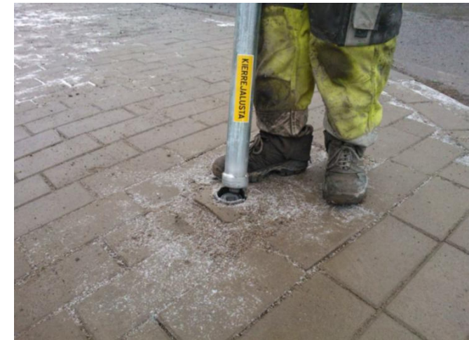
Exempel på jordskruvsfundament för vägmärke. Foto: Esa Perttula
