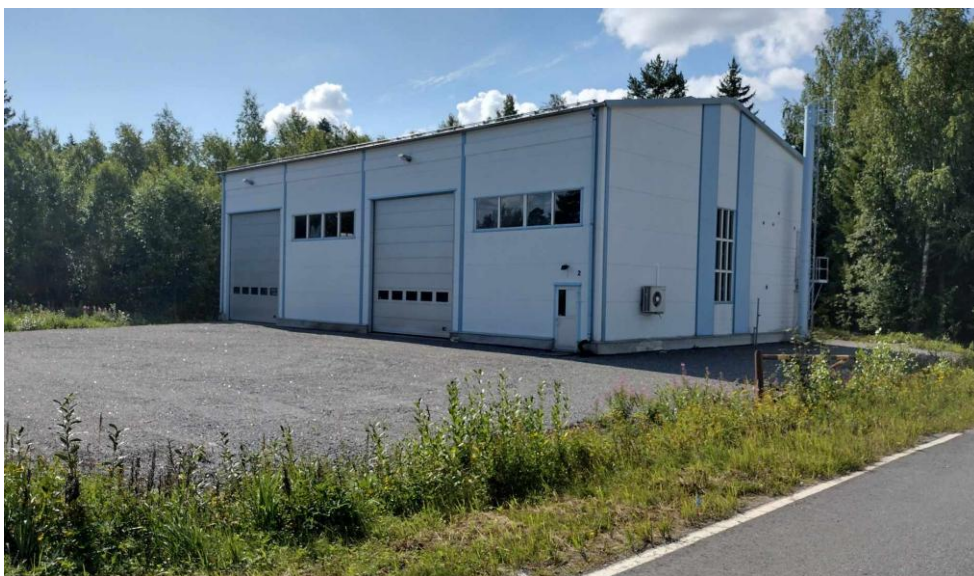
Bild 3. Byggnation på tomt 2 i kvarteret.
