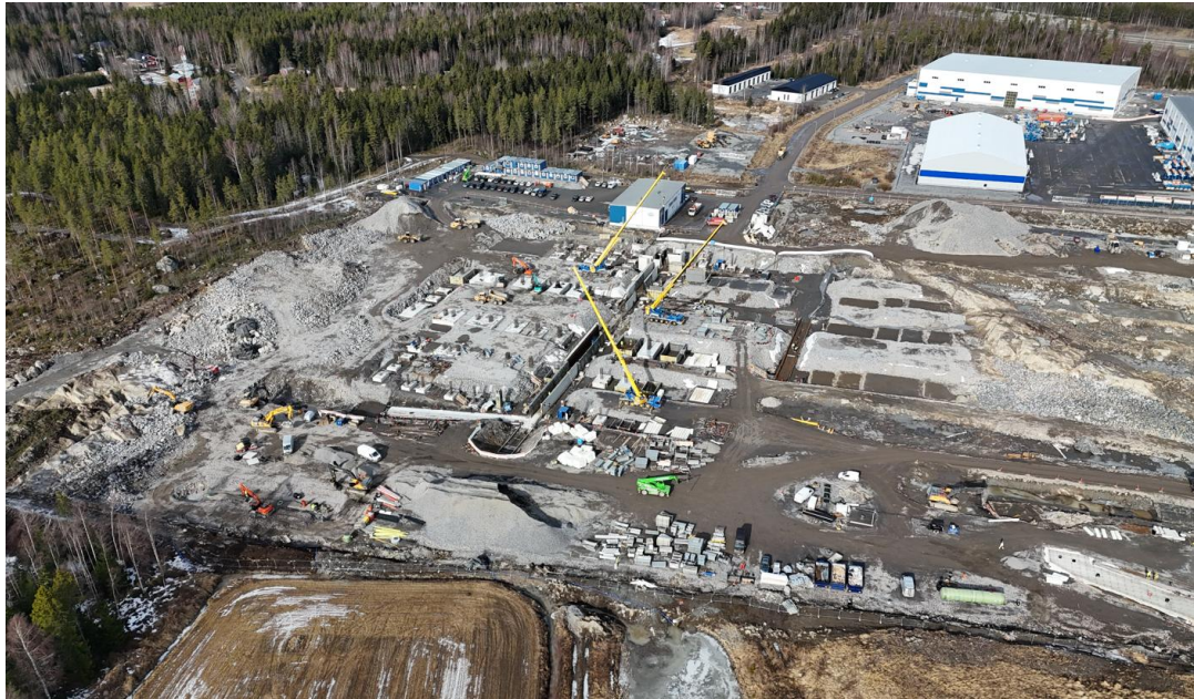
Kuva 19. Korttelin 24 tontin 1 rakentaminen maaliskuussa 2025.
