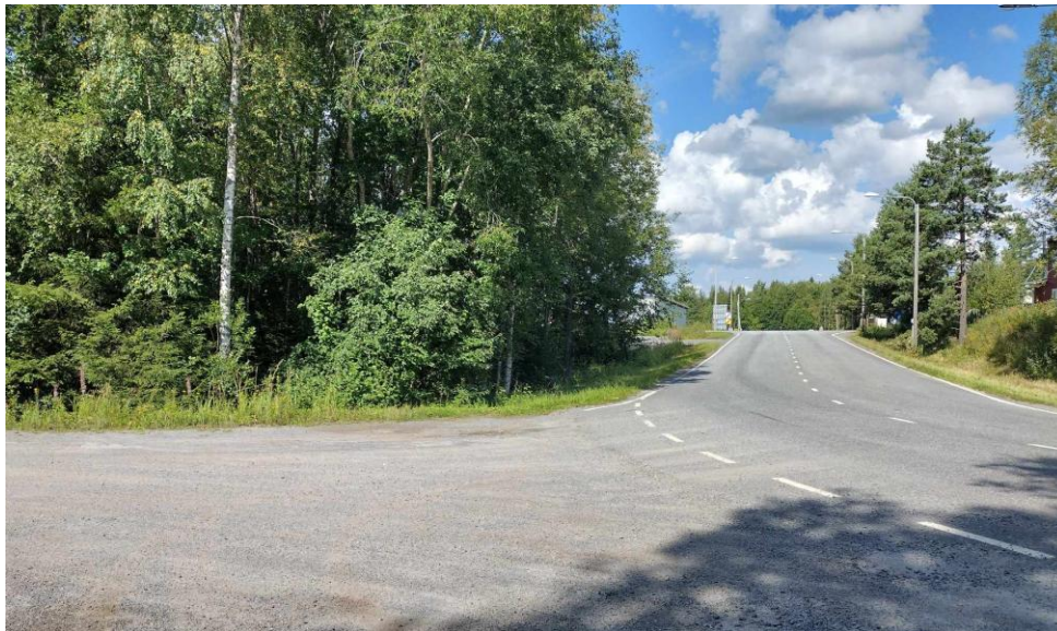
Kuva 5. Näkymä Varastotielle Pakastamontien liittymästä katsottuna.
