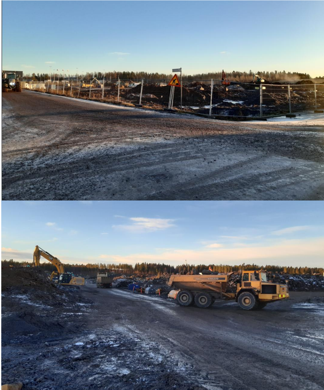
Kuva 4–5. Näkymä korttelin 24 tontille 1, jossa Hitachi Energy Finland Oy:n tuotanto- ja teknologiakampuksen rakentaminen on alkanut.
