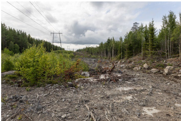
Bild 3. Under sommaren har det pågått underhållsarbeten under högspänningslinjen. Både norr och söder om högspänningslinjen växer ekonomiskog.
