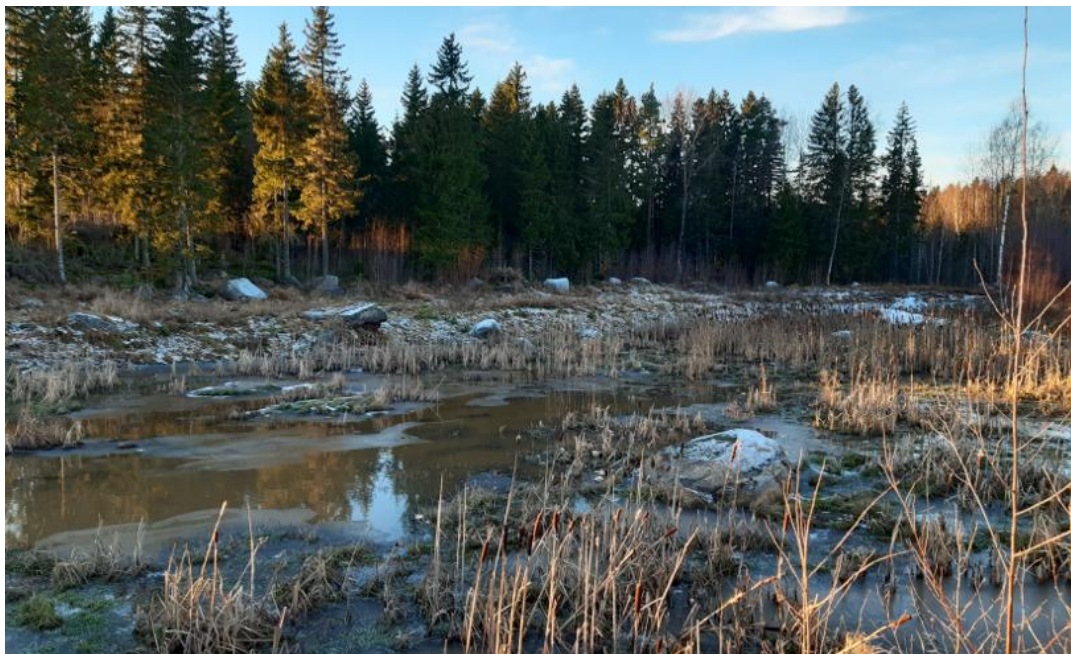
Bild 8. Dagvattenbassäng, vilken har byggts år 2021 mellan kvartersområde 20 och 21 (numrering enligt planförslag) inom skyddsgrönområde (EV-3).
