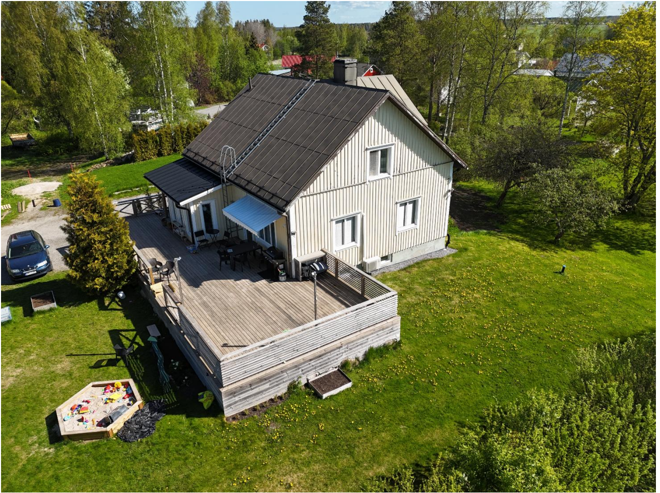
Kuva 3. Asuintalo lounaasta kuvattuna.
