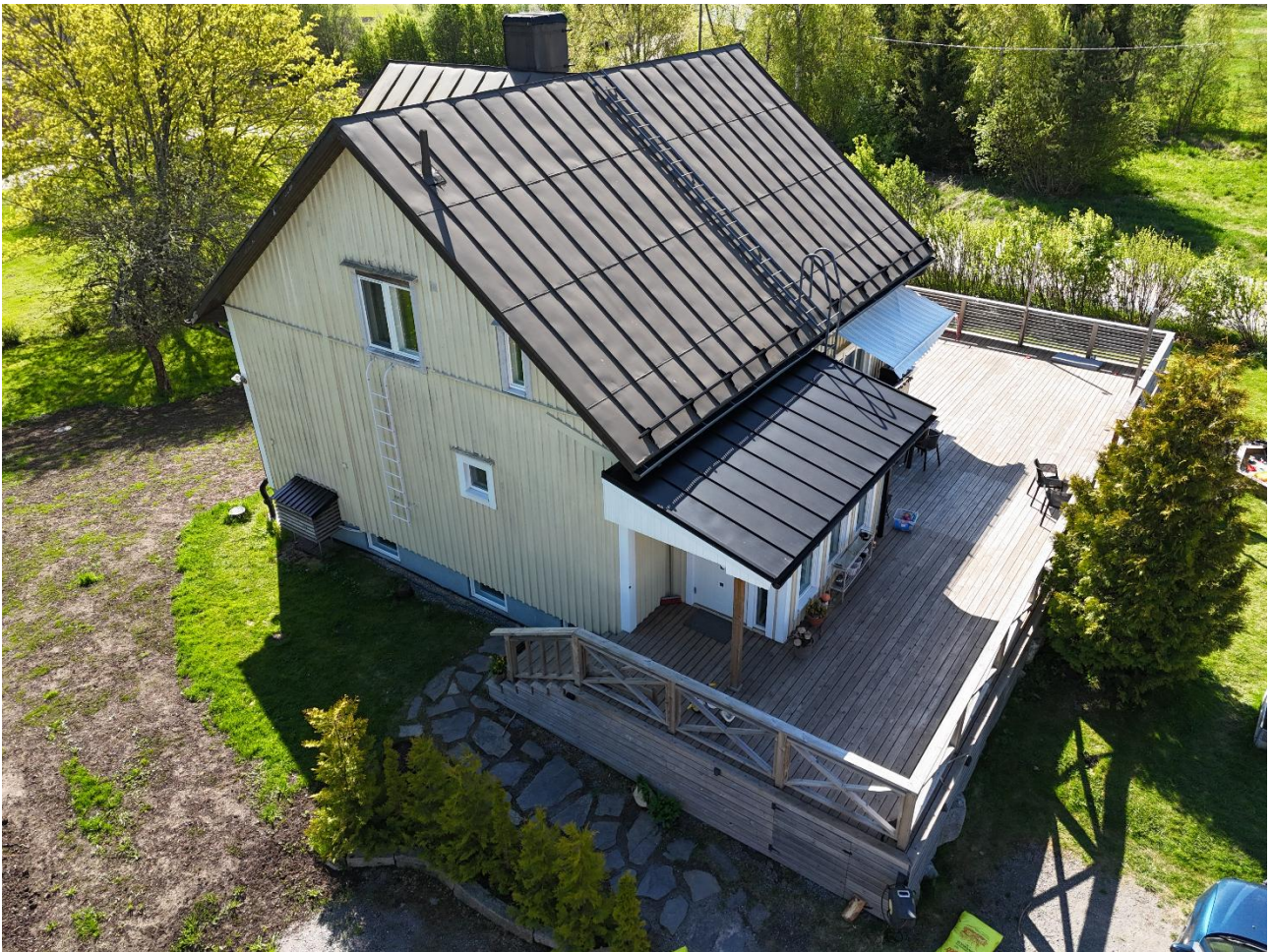
Kuva 2. Asuintalo luoteesta kuvattuna.
